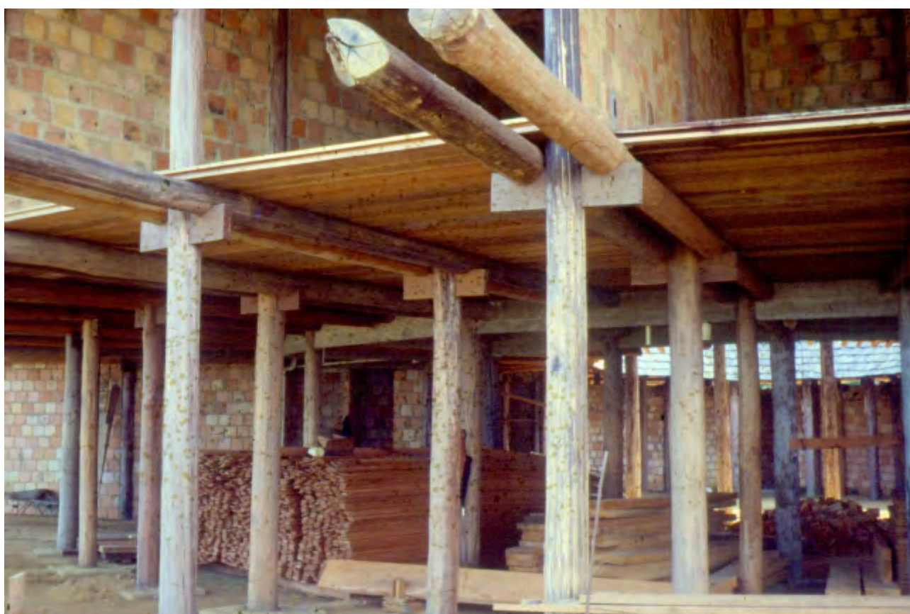
Figura 15 - Pousada da Ilha de Silves. Estrutura em construção, s.d. Fonte: Acervo Severiano Porto - NPD/UFRJ
