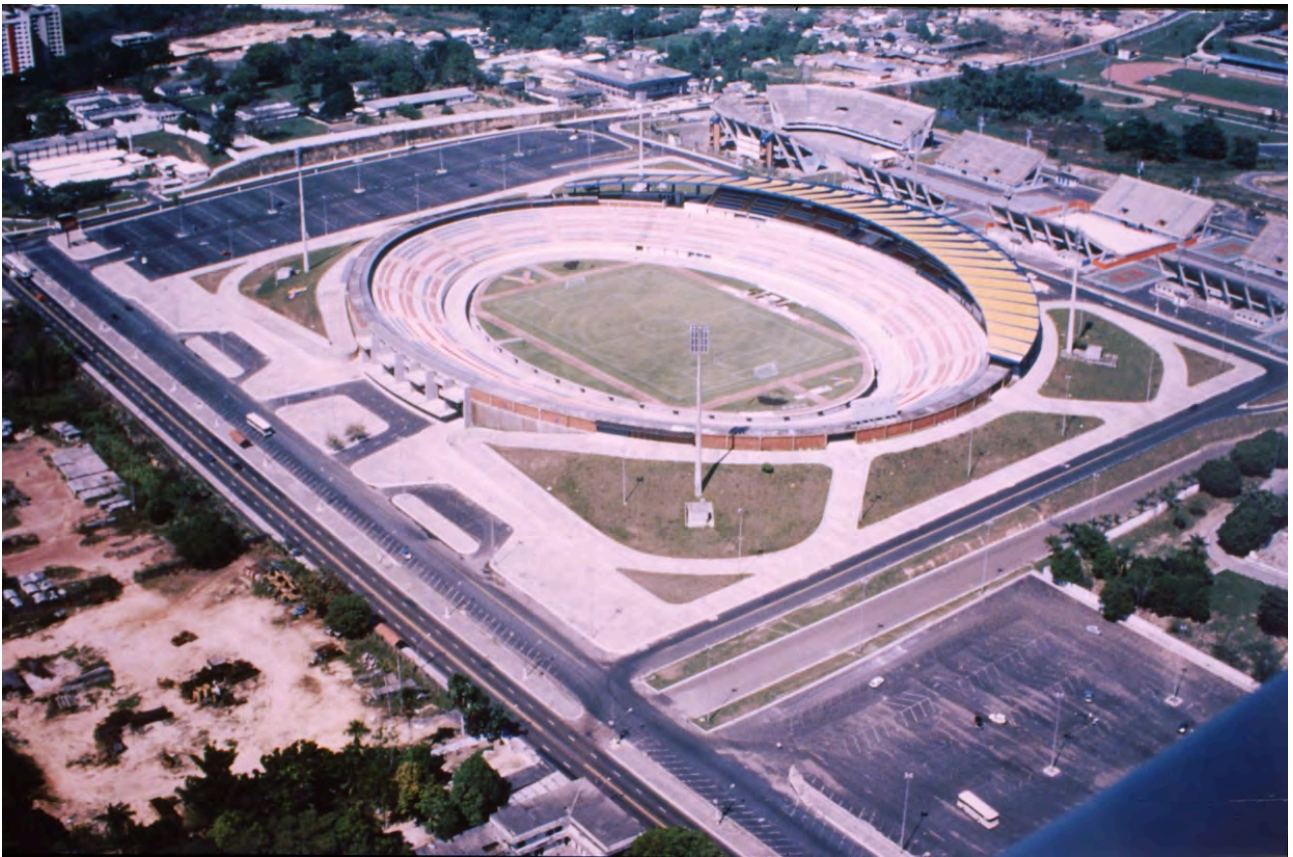
Figura 34 - Estádio Vivaldo Lima. Reforma, 1995. Fonte: Acervo Severiano Porto - NPD/UFRJ.
