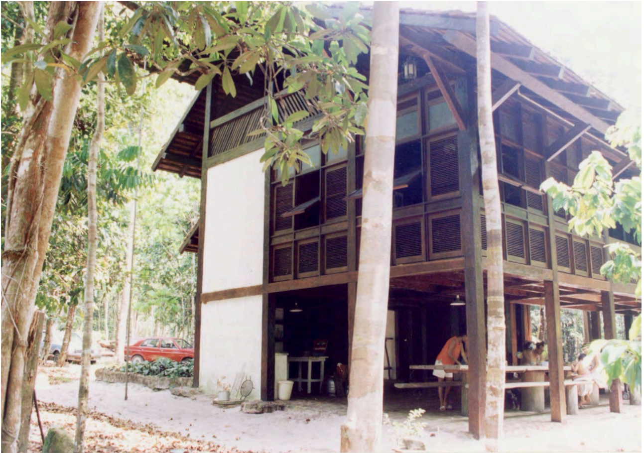
Figura 51 - Residência Robert Schuster, [entre 1979-1980]. Fonte: Acervo Severiano Porto.
