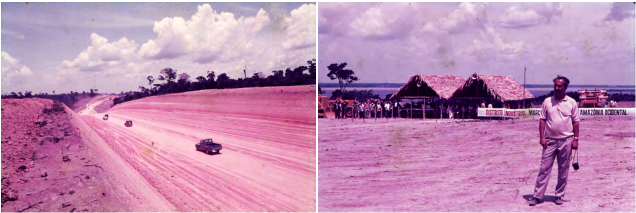
Figura 5 e 6 - Imagens das obras do Distrito Industrial I, 1971. Fonte: Acervo Severiano Porto.
