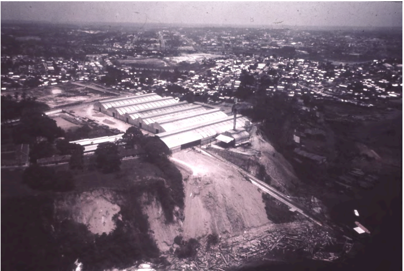
Figura 7 - Processo erosivo no Distrito Industrial I, 1971. Fonte: Acervo Severiano Porto.
