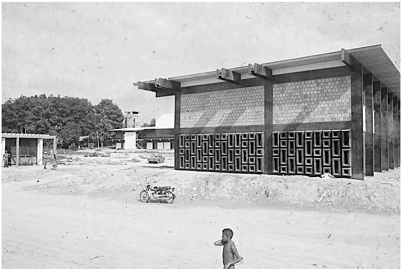
21_Bloco do Comando Geral. Polícia Militar do Amazonas Acervo Severiano Porto, [entre 1969 e 1970].
