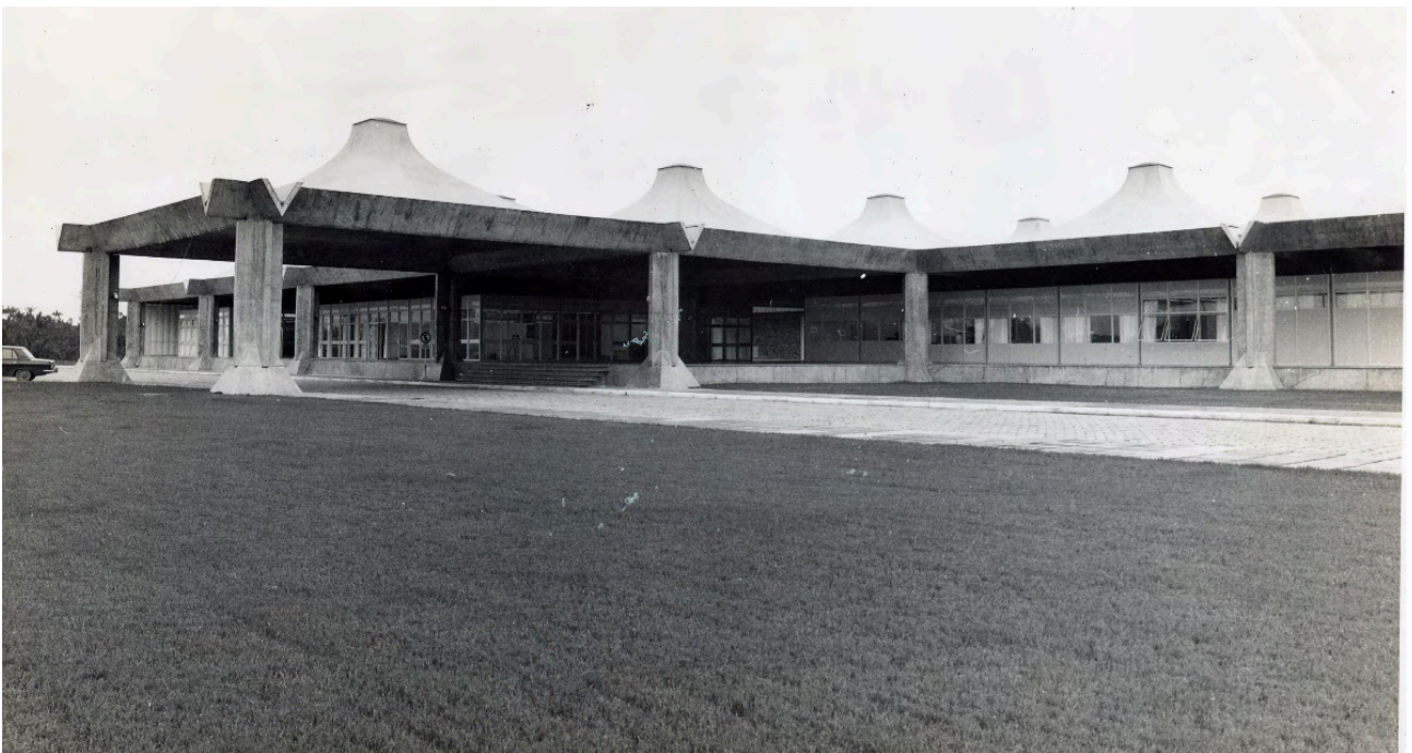
Figura 21, 22 e 23 - Sede da SUFRAMA, 1974. Fonte: Acervo Severiano Porto, NPD/UFRJ.
