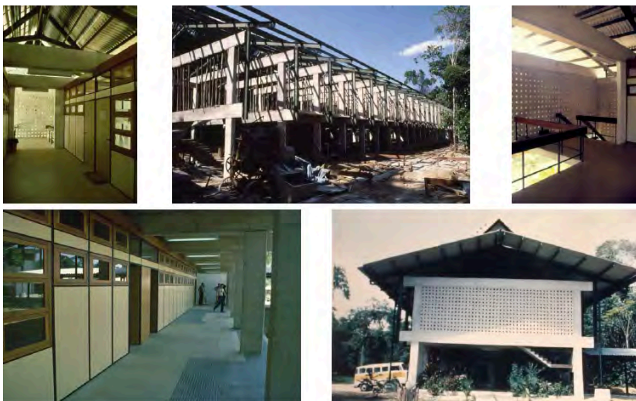
Figura 47,48, 49, 50 e 51 - Setor norte do campus da UA, Administrativo, Administração, s.d. Fonte: Acervo Severiano Porto.
