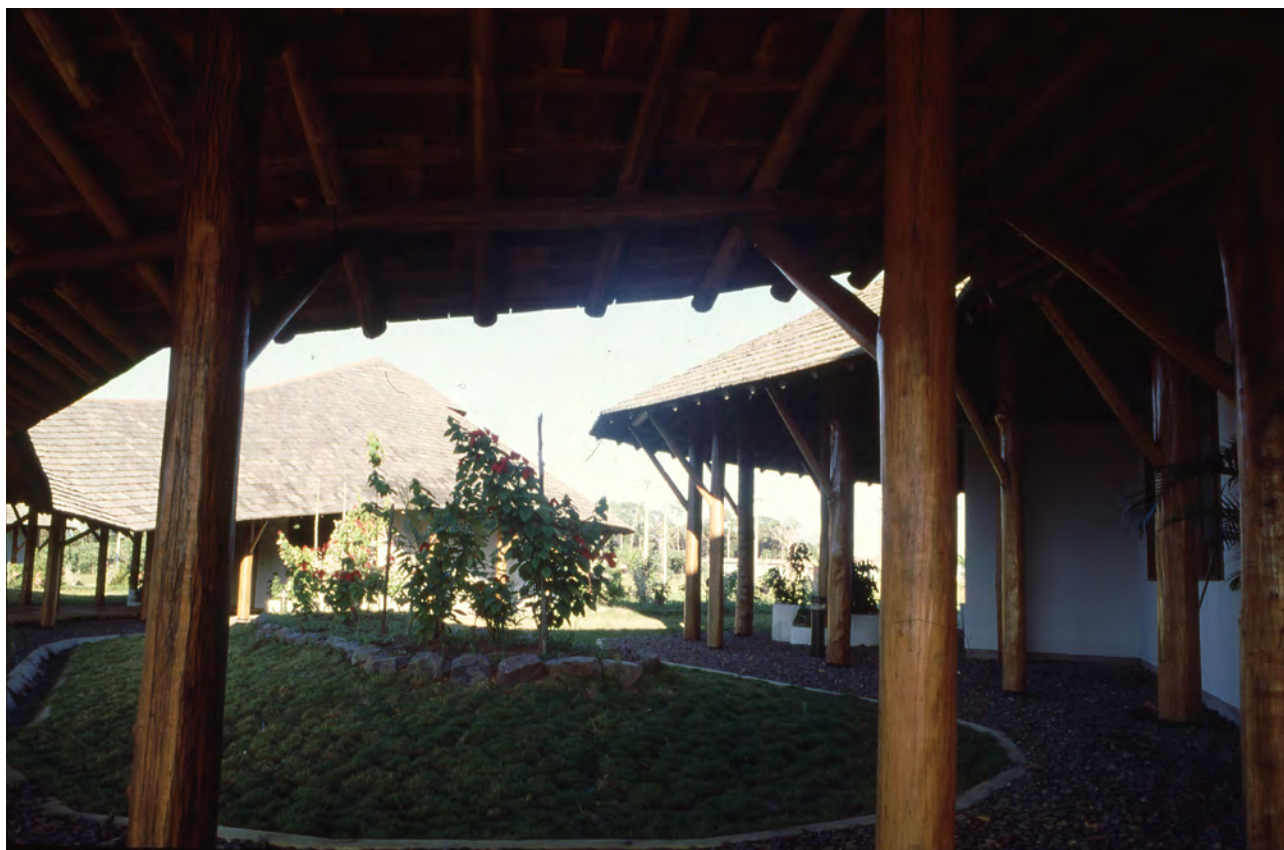
Figura 36 - Centro de Proteção Ambiental de Balbina. Praça entre os laboratórios polivalentes I e II, 1987. Fonte: Acervo Severiano Porto - NPD/UFRJ
