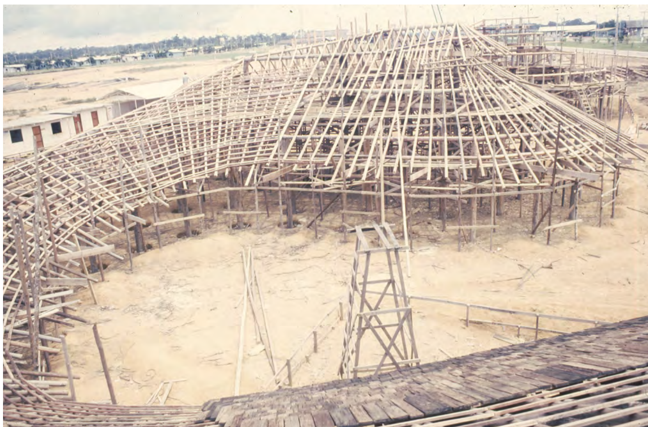
Figura 19 - Centro de Proteção Ambiental de Balbina. Cobertura em cavaco, 1986. Fonte: Acervo Severiano Porto - NPD/UFRJ
