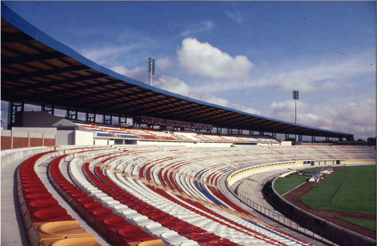
Figura 33 - Estádio Vivaldo Lima. Reforma, 1995. Fonte: Acervo Severiano Porto - NPD/UFRJ.
