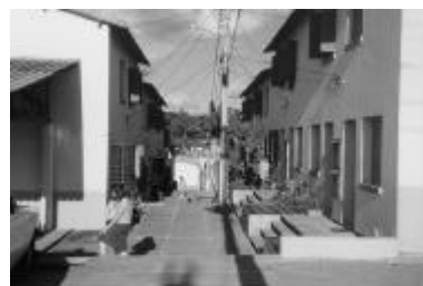
Acesso principal em desnível Conjunto habitacional São Jorge
