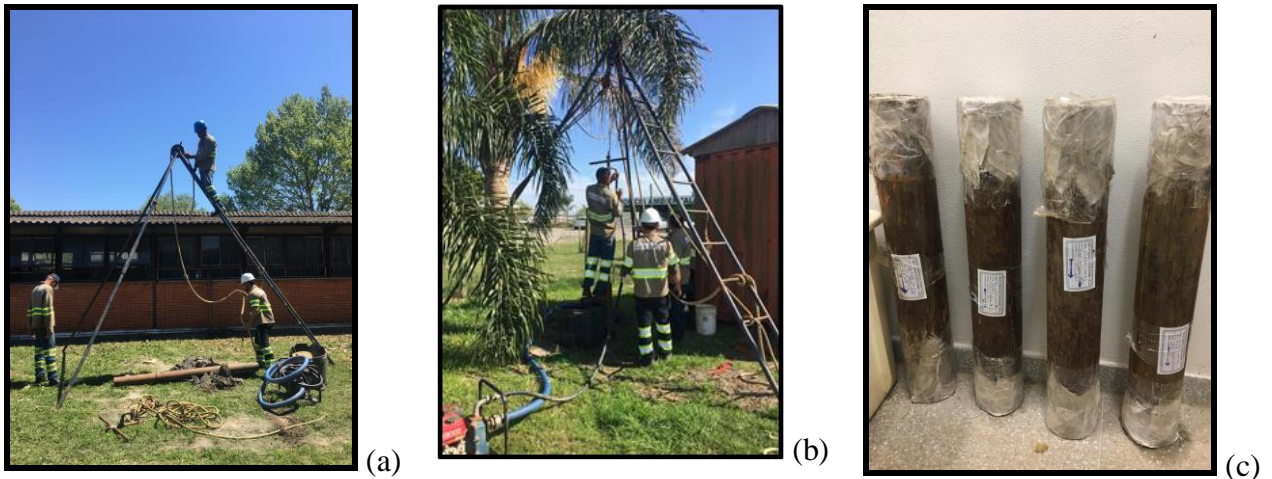
Figura 3.12: Retirada de amostras indeformadas: (a) montagem da estrutura auxiliar na Escola; (b) montagem da estrutura auxiliar no CCMar; e (c) acondicionamento dos tubos shelby em câmara úmida.
