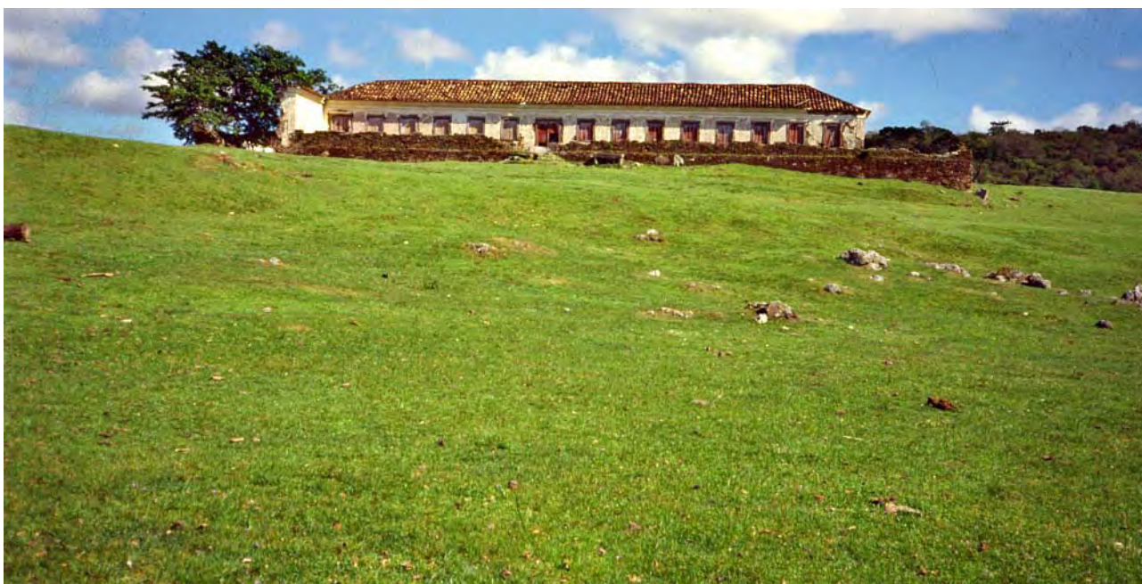
Figura 1: Estância do Cristal, em Canguçu, exemplificando a utilização de pontos elevados e orientação da fachada entre leste e norte. Fonte: autor.
