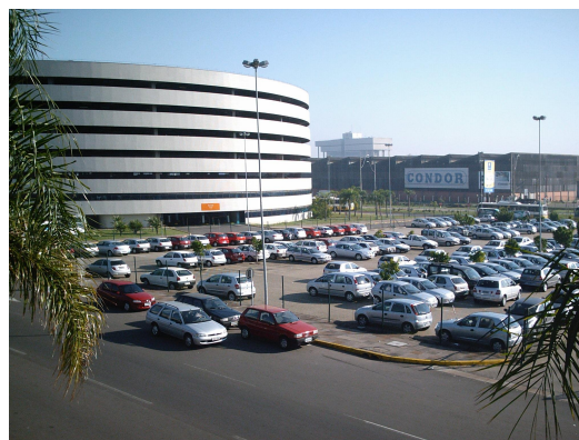
Figura 9 - Estacionamento do Aeroporto Salgado Filho, na Av. Severo Dullius.
