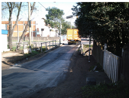
Figura 8 - Ponte ligando a Av. Dique à Av. das Indústrias.
