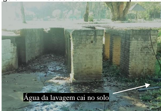
Figura 24 – Rampa sem drenagem total dos efluentes
