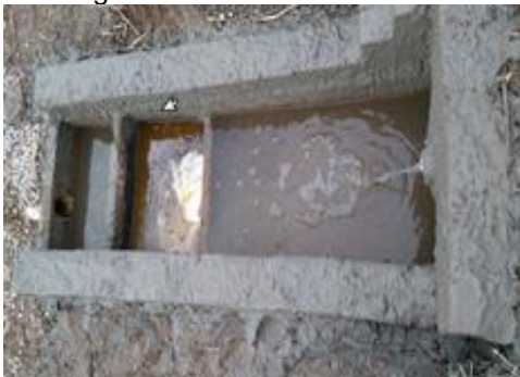
Figura 29 – SAO em alvenaria
