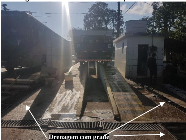
Figura 35 – Estrutura da rampa da OM 2
