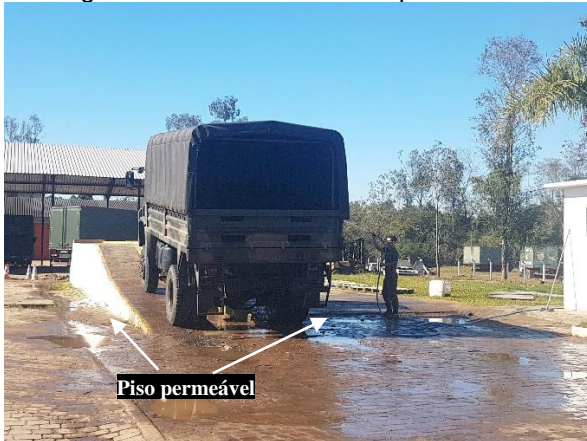
Figura 37 – Estrutura da rampa da OM 3
