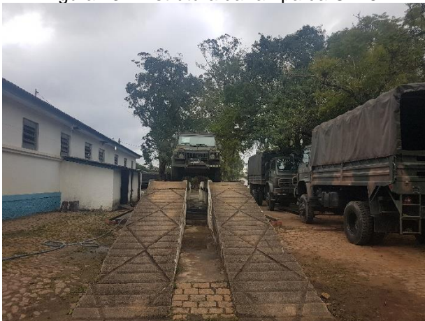
Figura 43 – Estrutura da rampa da OM 6
