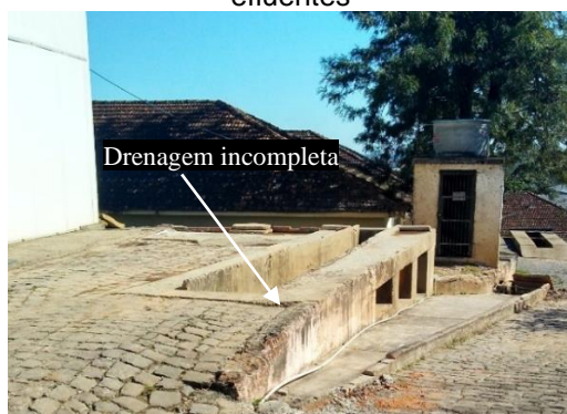
Figura 24 – Rampa sem drenagem total dos efluentes
