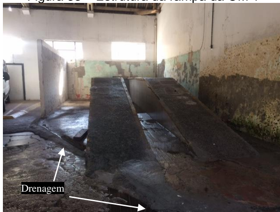
Figura 33 – Estrutura da rampa da OM 1
