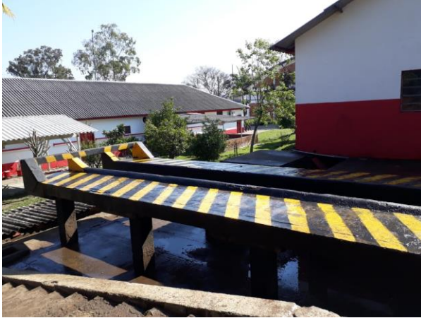
Figura 41 – Estrutura da rampa da OM 5
