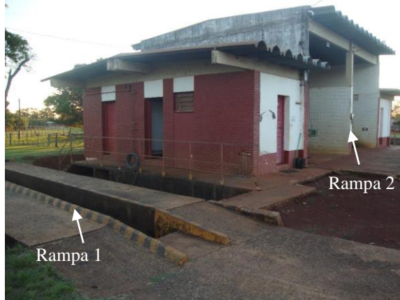
Figura 19 – Rampas de lavagens próximas
