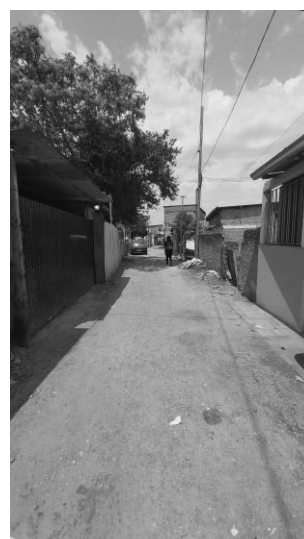
Figura 127 – Via existente no Quarteirão 8 Fonte: Acervo pessoal (2019)
