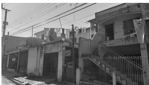
Figura 84 – Espaço físico da residência unifamiliar
