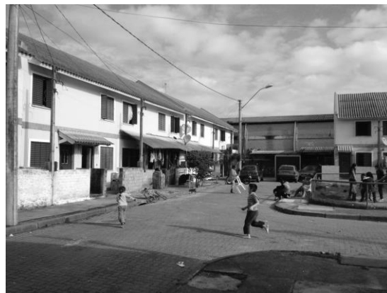
Figura 30 - EHIS Jardim Navegantes Fonte: próprio autor (2019)
