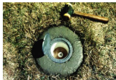
Figura 17: Colocação do colar de concreto.
