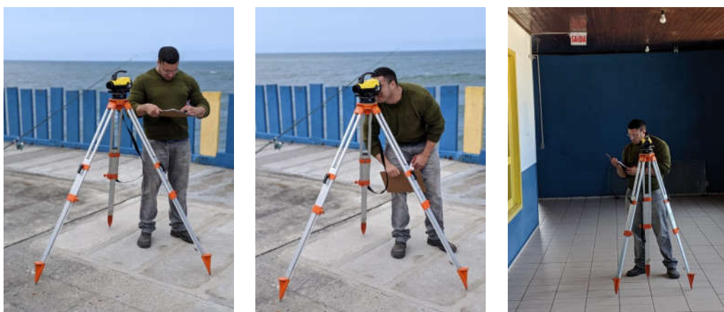
Figura 65: Nivelamento geométrico com nível óptico digital.
