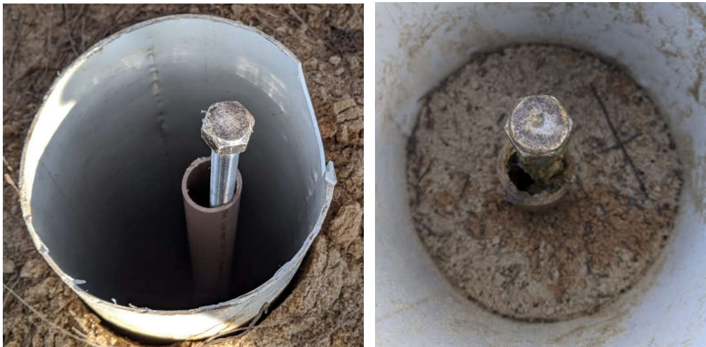
Figura 48: (Esq.) Cabeça protetora da haste rosqueada contra as marretadas para evitar a deformação da rosca; (Dir.) Haste dentro do pvc de ½" com graxa, e preenchido exteriormente com areia.
