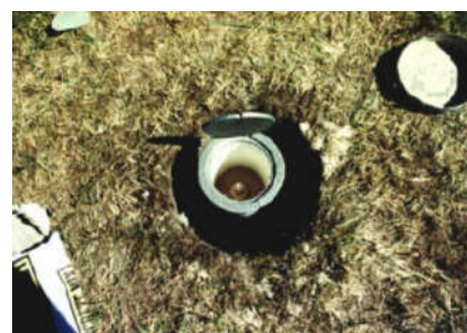
Figura 16: Colocação do 2º cano de PVC preenchido com areia.
