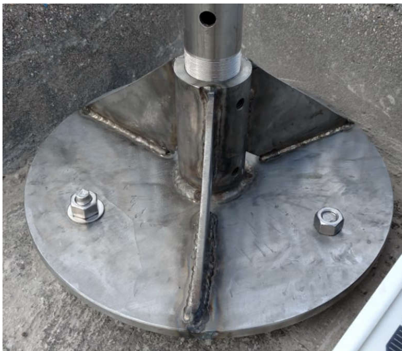
Figura 31: Pedestal do Mastro e os 3 Parafusos para o seu Nivelamento.
