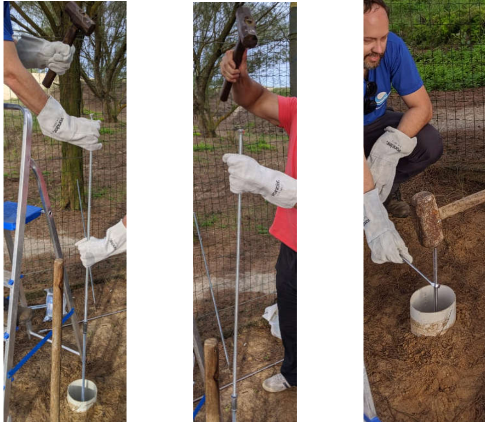
Figura 47: Processo de estaqueamento manual da RN de profundidade via marreta de 1kg e 5kg.
