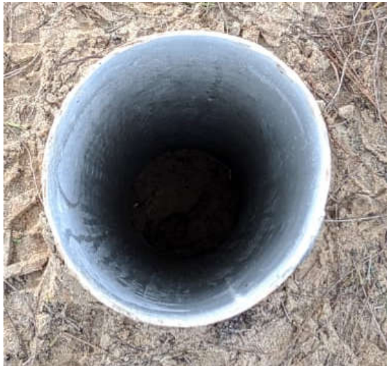
Figura 45: Cano de PVC de 5" x 1,20 m de profundidade colocado no solo.
