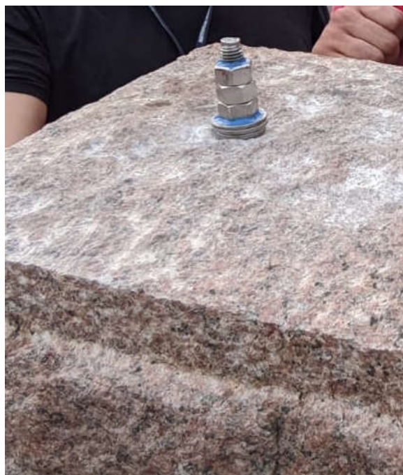
Figura 37: Pino de centragem forçada implantado no granito externo ao estacionamento da plataforma de pesca.
