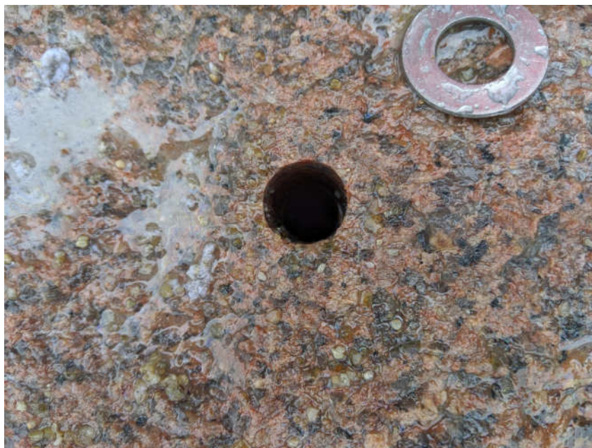
Figura 36: Furo para o chumbador do pino de centragem forçada molhado para o arrefecimento das brocas diamantadas.
