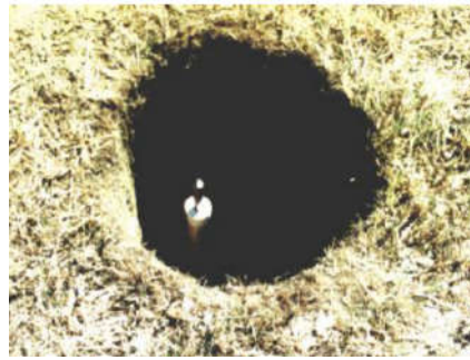
Figura 15: Colocação do 1º cano de PVC com graxa.
