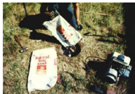
Figura 16: Colocação do 2º cano de PVC preenchido com areia.
