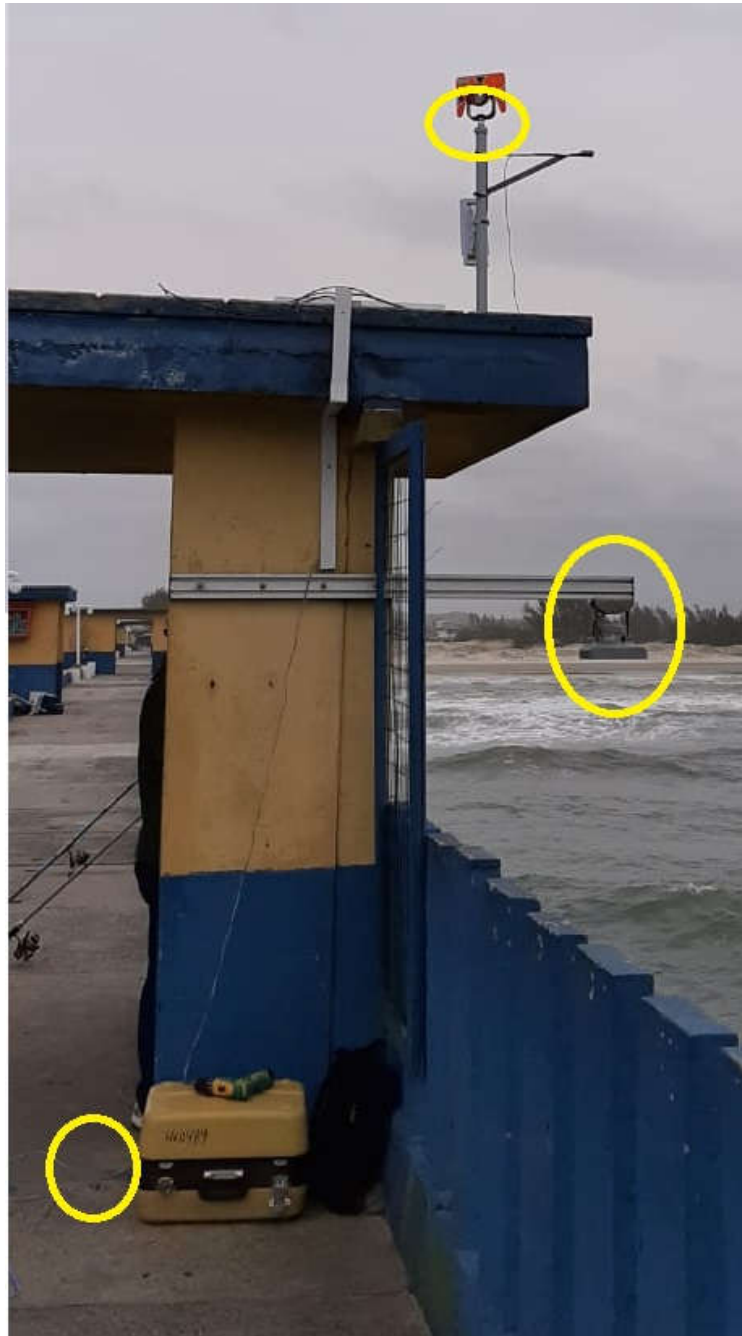
Figura 69: Pontos de interesse, no canto inferior esquerdo temos as RNs da UFRGS e EPAGRI, ao centro e a direita o marégrafo, e acima o topo do mastro.
