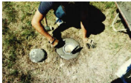
Figura 17: Colocação do colar de concreto.
