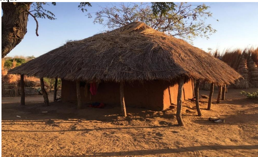
Figura 16 - A “palhota” como o tipo de habitação predominante desta tipologia de agricultores, Gaza/Moçambique
