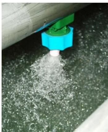
Figura 3.18 – Esguicho marca Bete montado em um túnel de pasteurização
