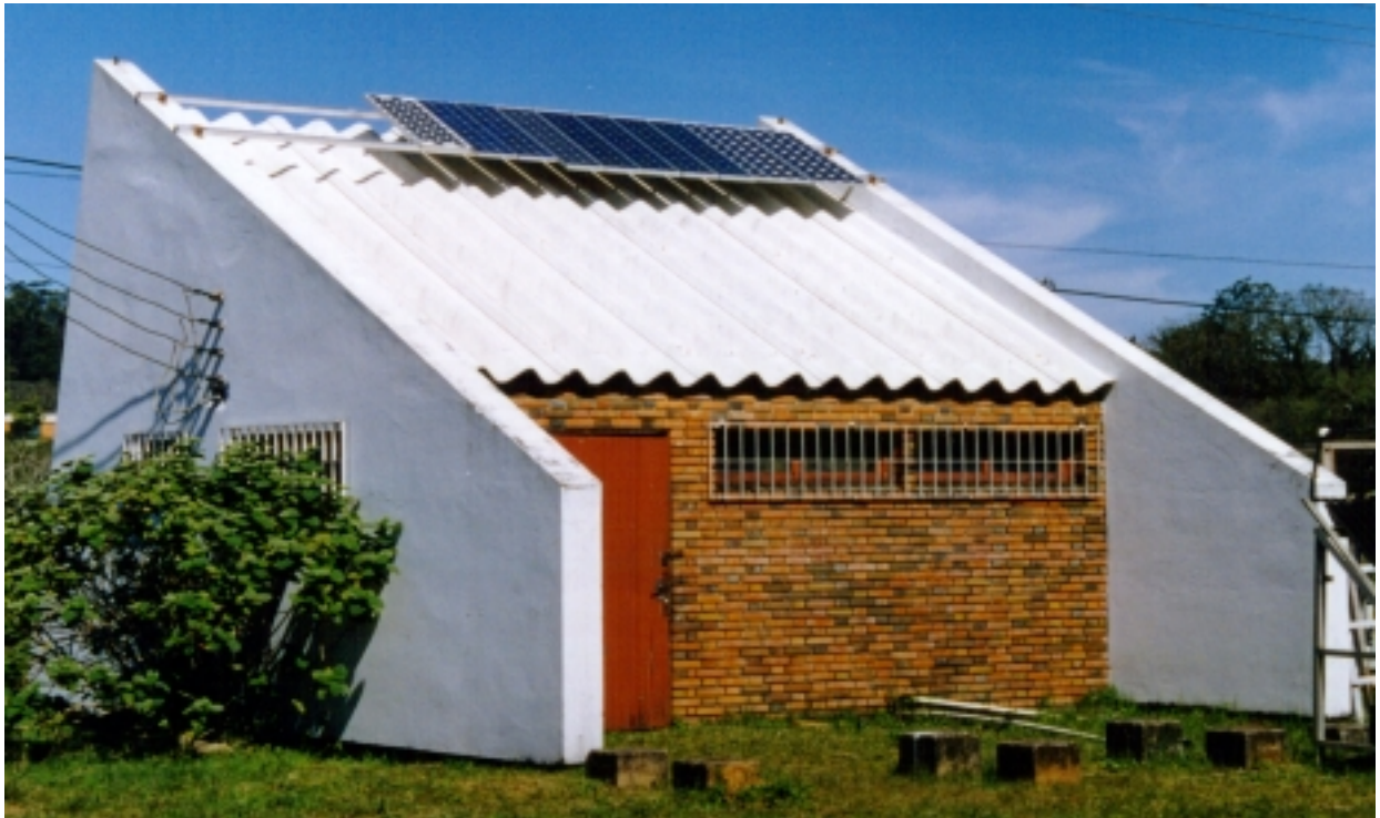
FIGURA 6.2 - Sistema fotovoltaico experimental.
