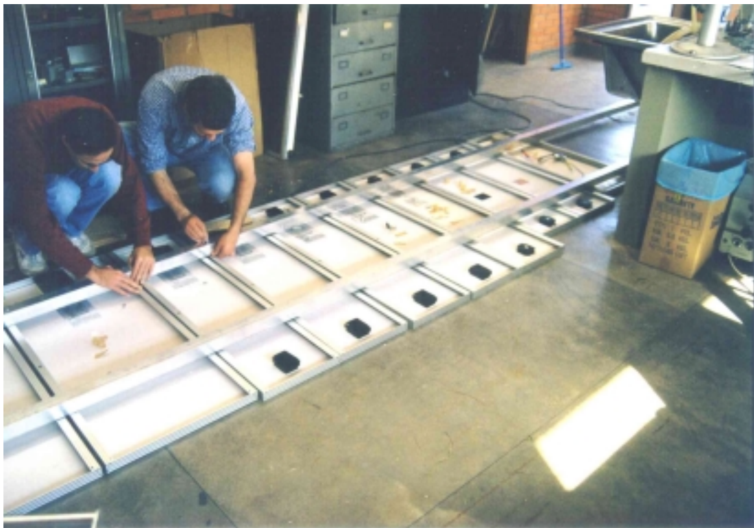
FIGURA 6.1 – Detalhes da montagem dos módulos fotovoltaicos do sistema.
