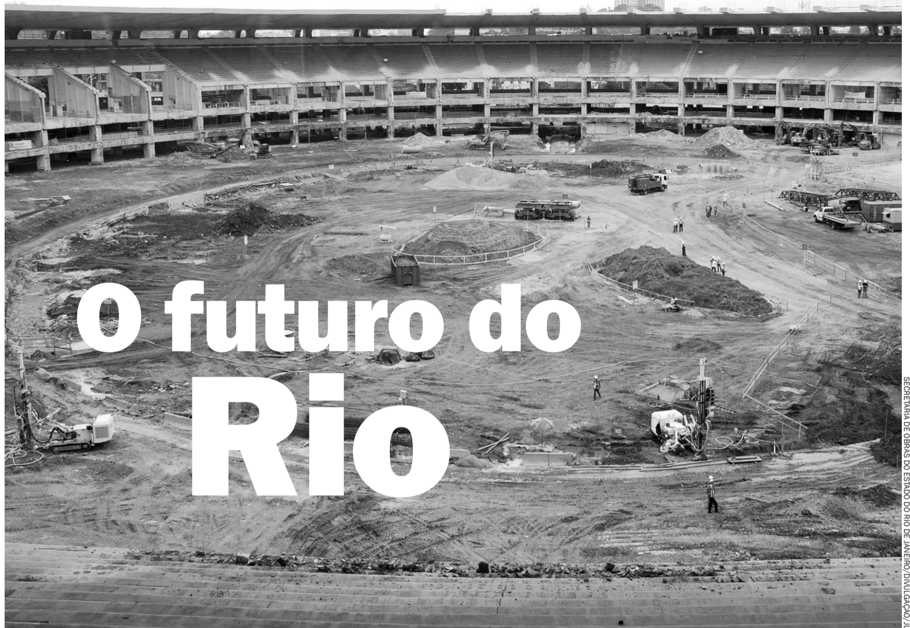
As obras do estádio Maracanã, cujo custo final deve chegar a 1 bilhão de reais, devem estar concluídas até dezembro de 2012
