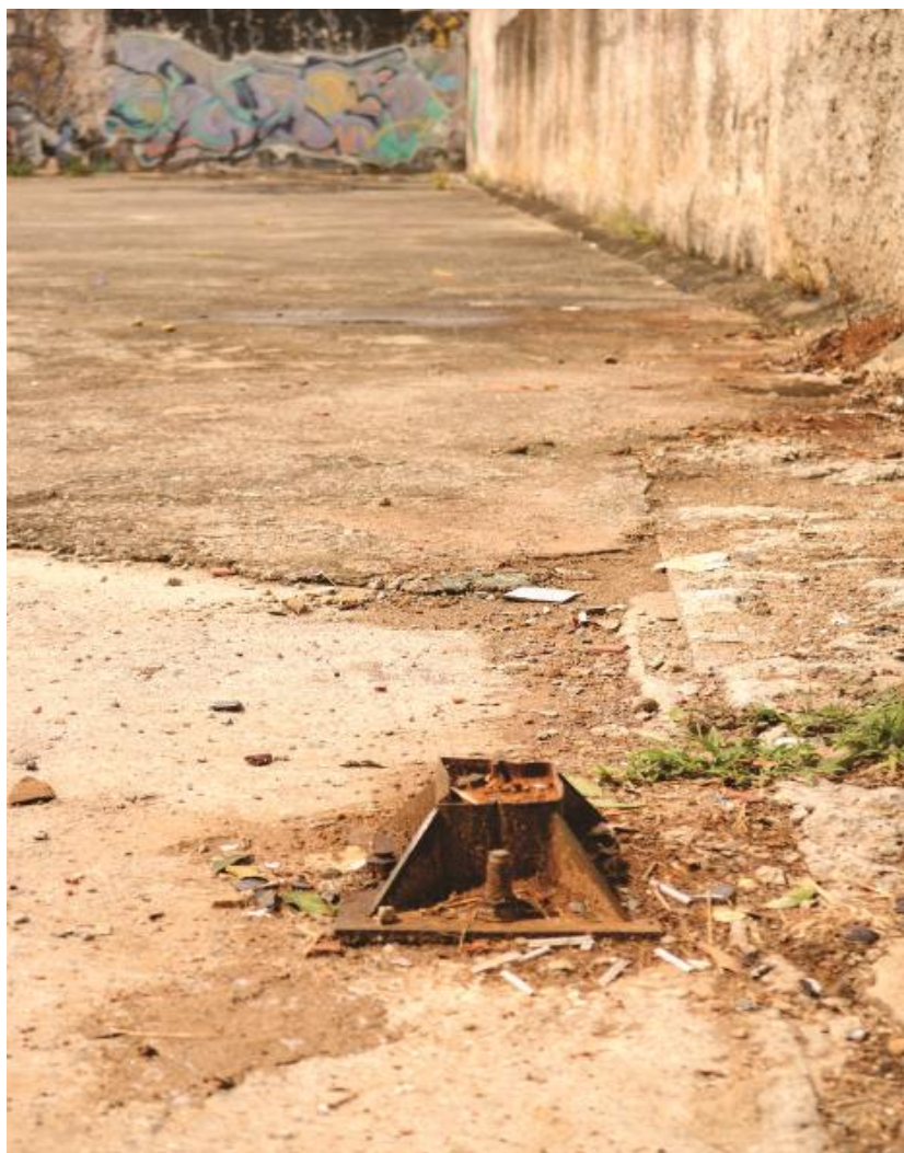
Imagem 15 - Estrutura metálica remanescente Fonte: Ana Laura Carvalho Nunes, 2019
