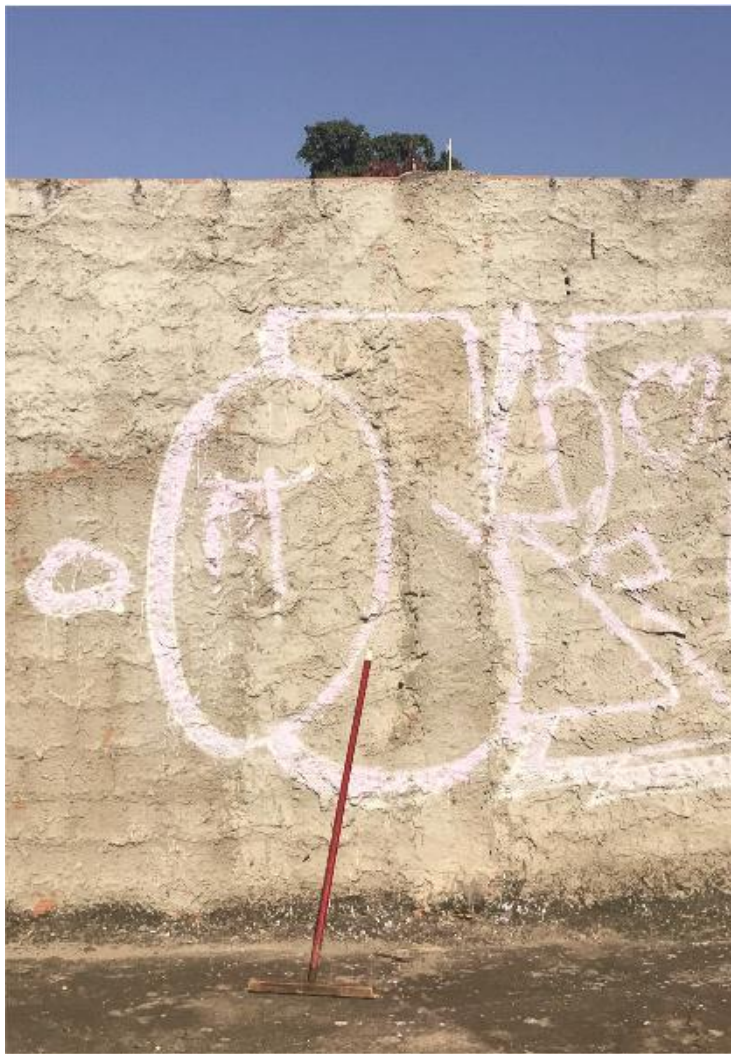
Imagem 9 - Equipamento de limpeza e manutenção no lote concretado da Rua 57 Fonte: Ana Laura Carvalho Nunes, 2019
