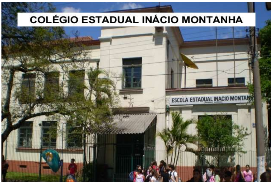
Figura 3: Colégio Estadual Inácio Montanha. Fonte: da autora
