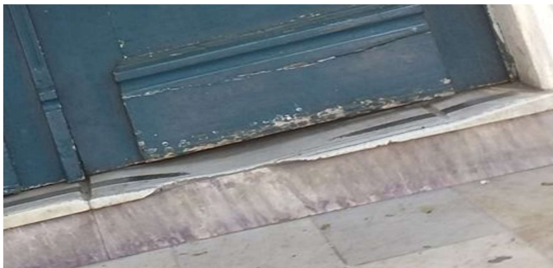
Imagem 11: Entrada do colégio com mármore erodido por ser pisado há 85 anos.
