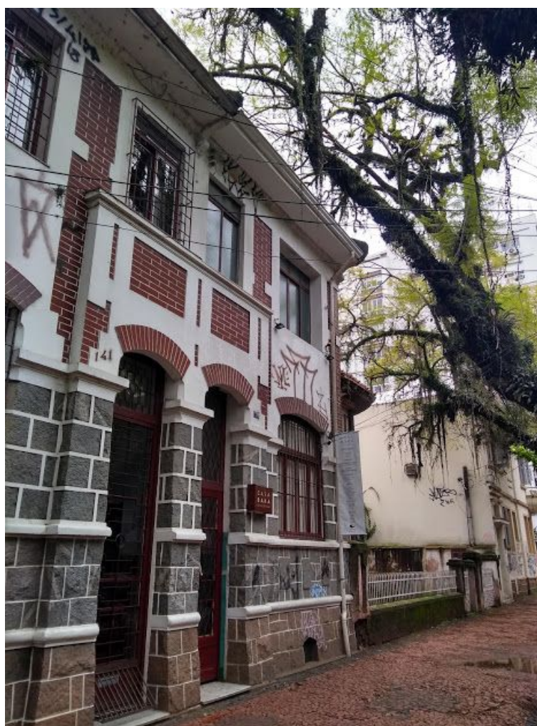
Fotografia 1 - Fachada Casa Baka
