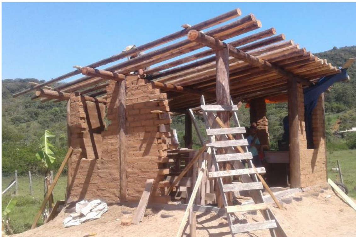
Figura 10: construção de uma residência em alvenaria de adobe em Imbituba/SC Fonte: Cecilia Prompt; VENDRAMI (2018)
