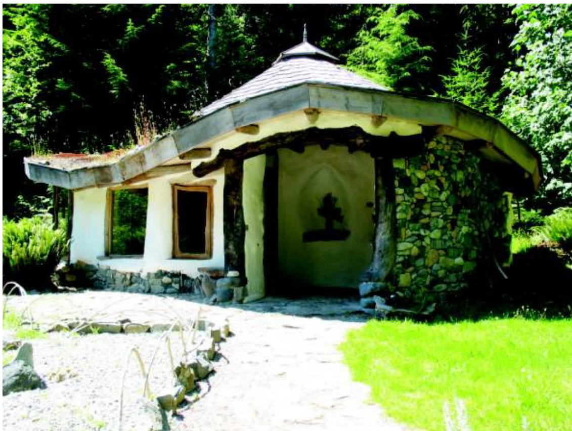
Figura 6: casa construída em Cob e alvenaria de pedra. Fonte: Gerry Thomasen; PROMPT (2008)
