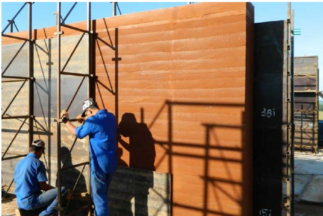
Figura 7: construção de uma parede em taipa de pilão. Fonte: TAIPAL (2018); VENDRAMI (2018)
