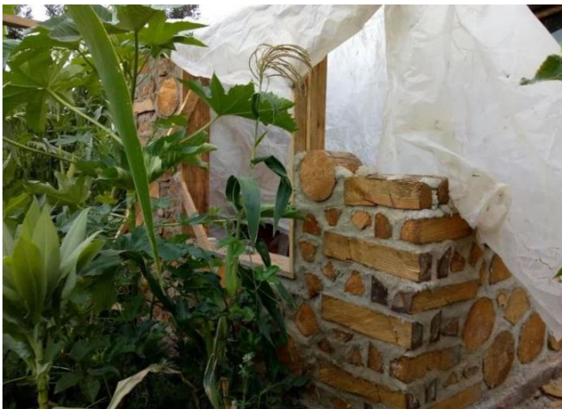
Figura 13: paredes em execução com técnica de cordwood. Fonte: (ALENCASTRO E SILVA, 2019)
