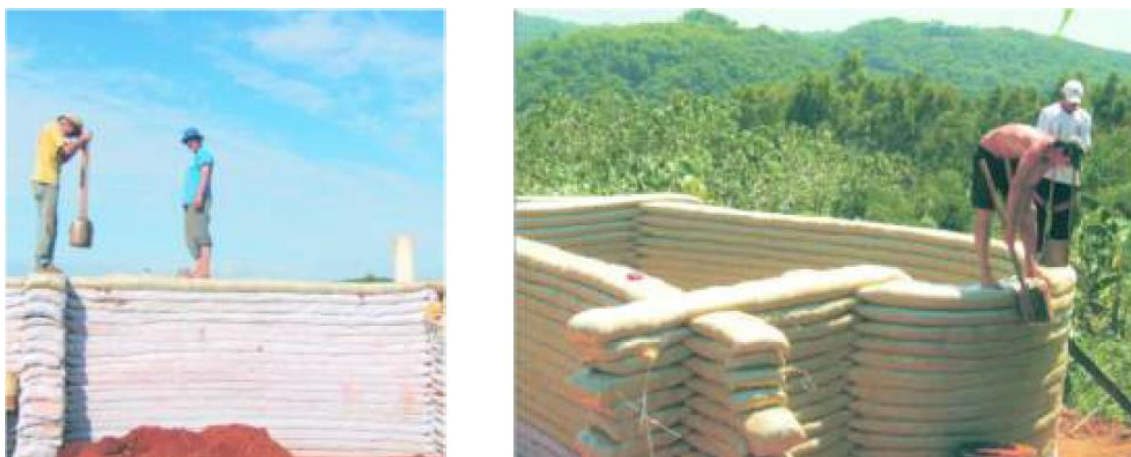
Figuras 8 e 9: compactação superior (esquerda) e lateral (direita) das paredes da sede do Instituto Morro da Cutia, em Montenegro/RS. Fonte: IMCA; PROMPT (2008)
