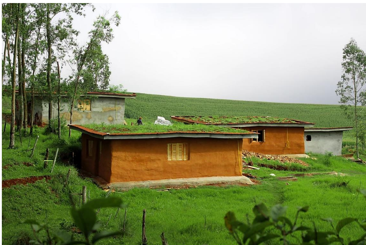
Figura 2: construção da Ecovila Dom José em Alpestre/RS. Fonte: UniPermacultura
