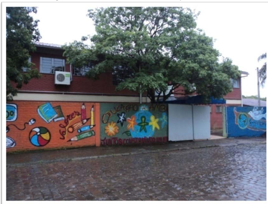
Figura 12 - Vista frontal da Escola com o portão aberto
