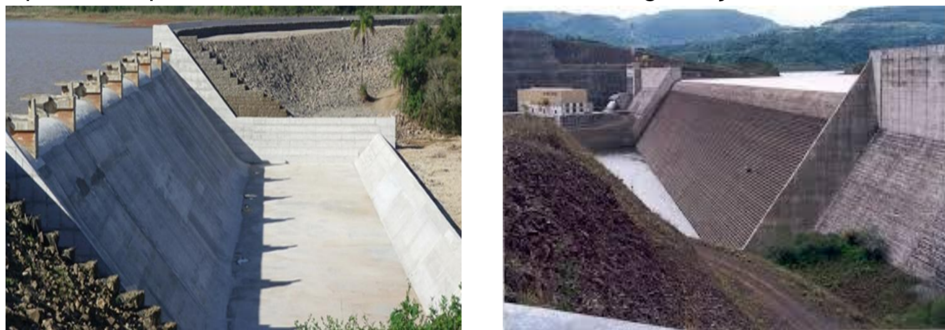
Figura 1: Vertedouro calha lisa (UHE Ernestina/ RS) e vertedouro com calha em degraus (UHE Dona Francisca/ RS)
