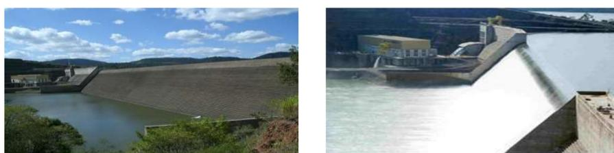
Figura 1: Vertedouro em degraus da UHE Dona Francisca.
