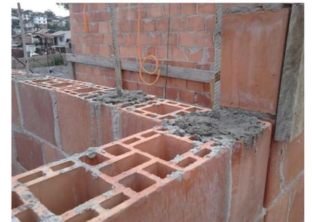
Imagem 1 – grautes executados em obra de alvenaria estrutural
