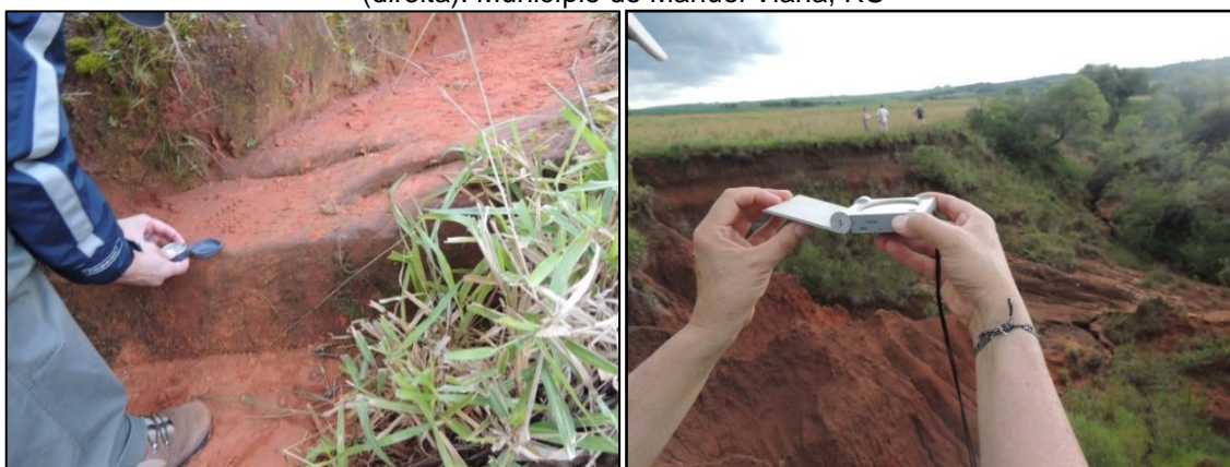
Figura 27 – Aferição da direção de falhas, no interior de ravinas (esquerda) Aferição da inclinação e direção do acamamento dos estratos da Formação Botucatu e Guará, localizada abaixo do solo e da formação superficial, no fundo da ravina, e que interfere, no desenvolvimento da erosão lateral (direita). Município de Manuel Viana, RS
