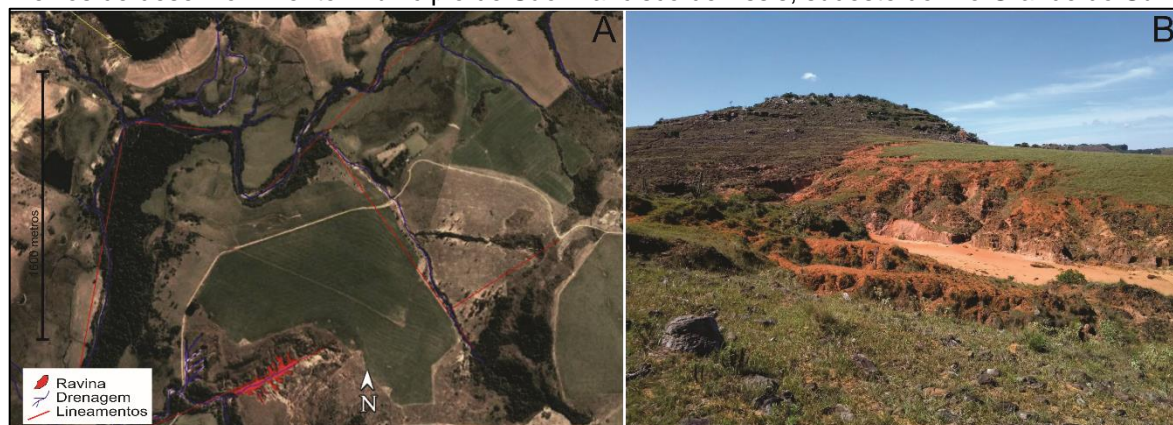
Figura 41 – Vista geral da Ravina 6 e de seu entorno, como delimitação das drenagens, dos lineamentos e do leito do processo erosivo (A). Em (B), vista lateral direita parcial da erosão e seus eixos de desenvolvimento. Município de São Francisco de Assis, sudeste do Rio Grande do Sul
