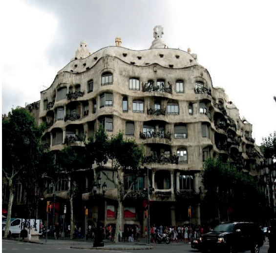
La Pedrera. Foto do autor
