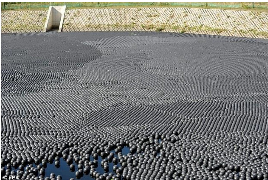
Figura 29 – Coberturas Flutuantes Modulares para Redução de Evaporação
