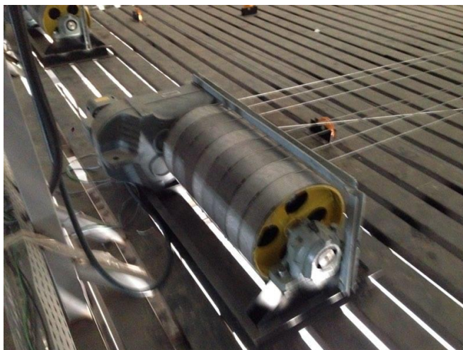
Figura 2.1 – Equipamento de acionamento automático de varas de iluminação instalado em um urdimento.
