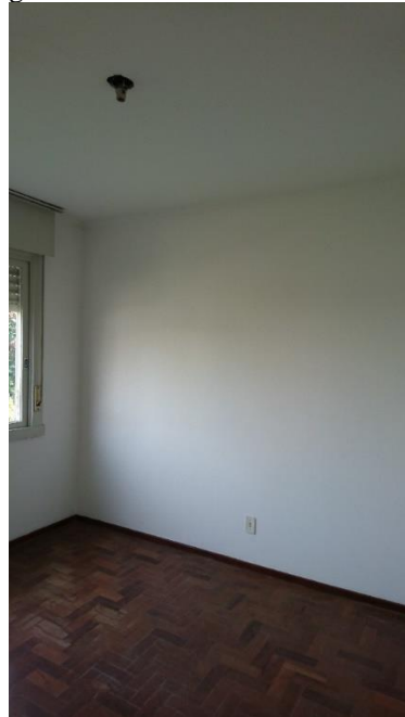
Figura 9 - Dormitório antes da reforma
