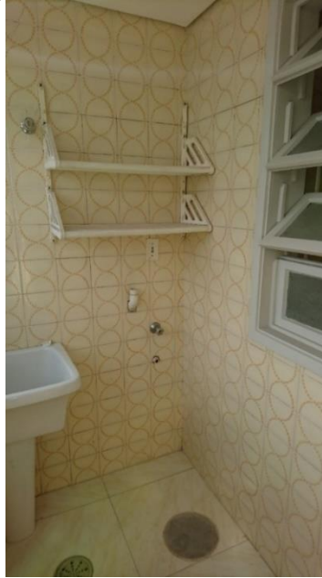
Figura 16 - Lavanderia antes da reforma
