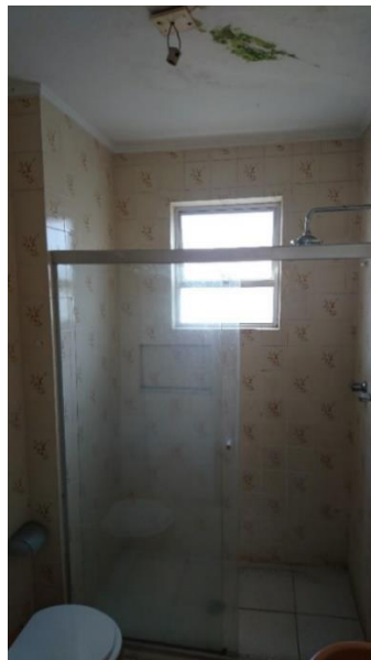
Figura 7 - Banheiro social antes da reforma
