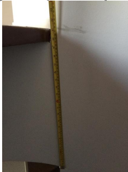
Figura 25- Medição de altura da laje
