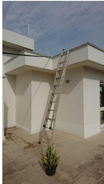
Figura 21 - Local onde será construída a cozinha no pavimento superior
