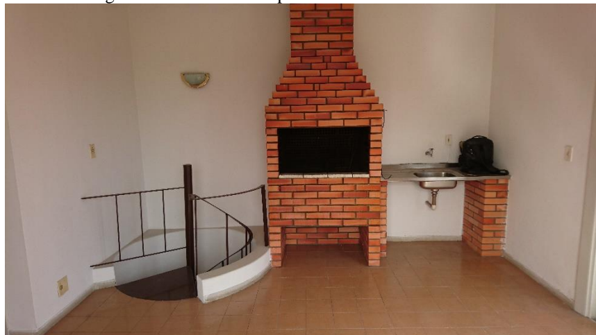
Figura 19 - Pavimento superior antes da reforma
