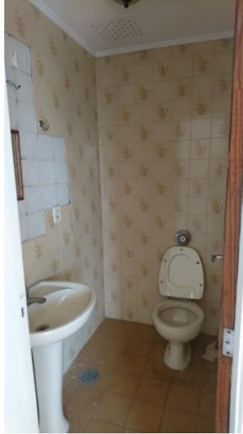
Figura 22 - Lavabo do pavimento superior, antes da reforma
