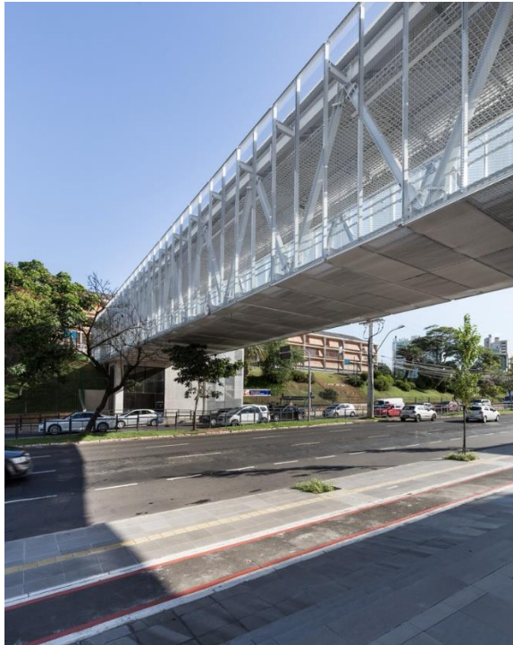
Figura 2 - Vista aproximada da passarela existente
