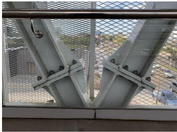
Figura 9 - Ligações parafusadas nas diagonais
