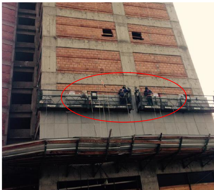
Foto 9: Instalação de revestimentos por um funcionário em cada andaime suspenso 53
