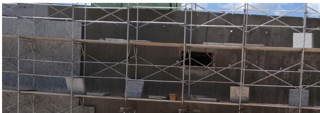
Foto 18: Fachada abastecida com as placas
