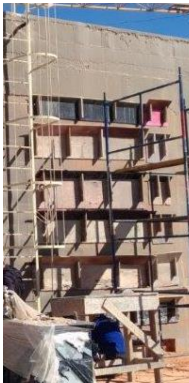
Foto 2: Forma para concretagem dos Coxins
