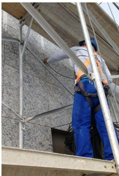
Foto 22: Inserção do limitador de junta
