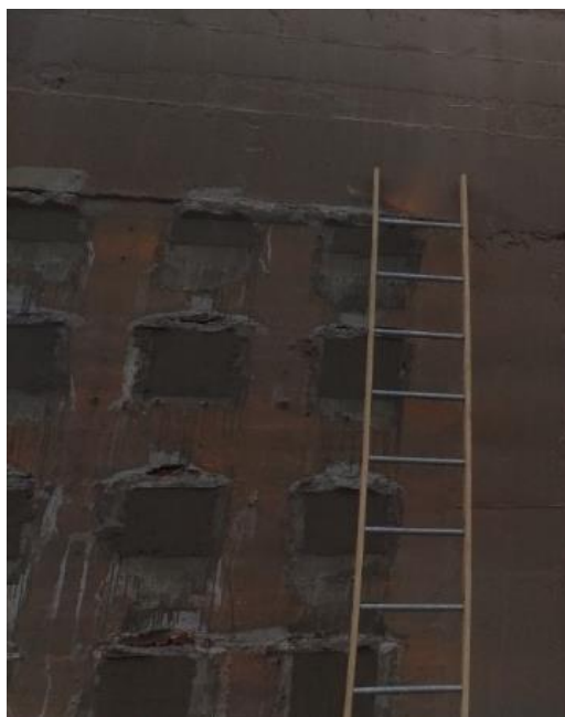
Foto 3: Coxins concretados e preparados
