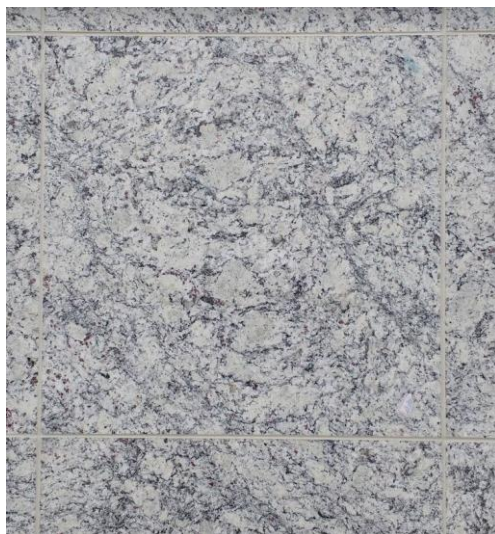
Foto 25: Placas com acabamento finalizado
