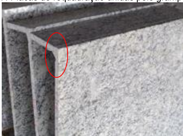
Foto 7: Placas de requadração unidas pelo grampo GA2
