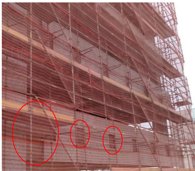
Foto 11: Trabalho em progresso devido as hastes de contraventamento
