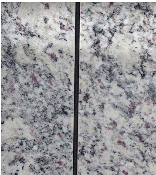
Foto 23: Limitador dentro da junta
