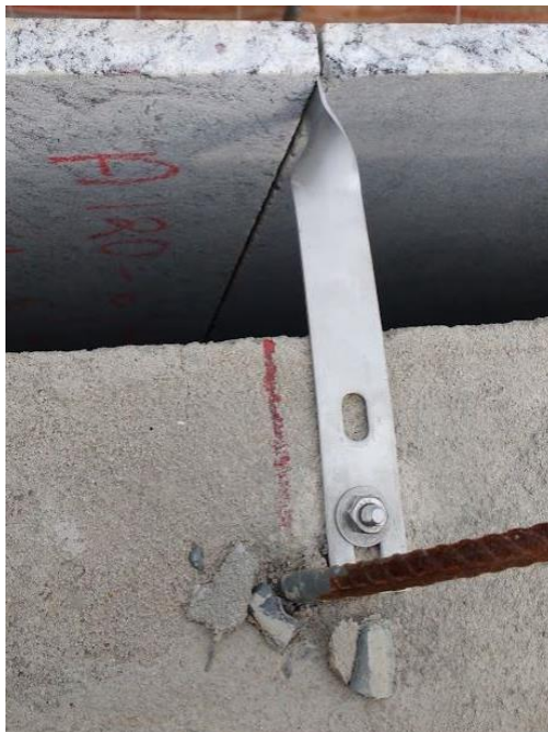
Foto 19: Marcação topográfica do alinhamento vertical
