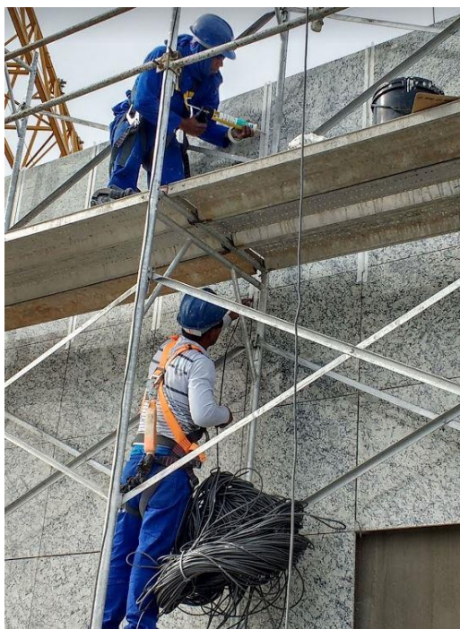
Foto 24: Aplicação do rejuntamento com uso de pistola
