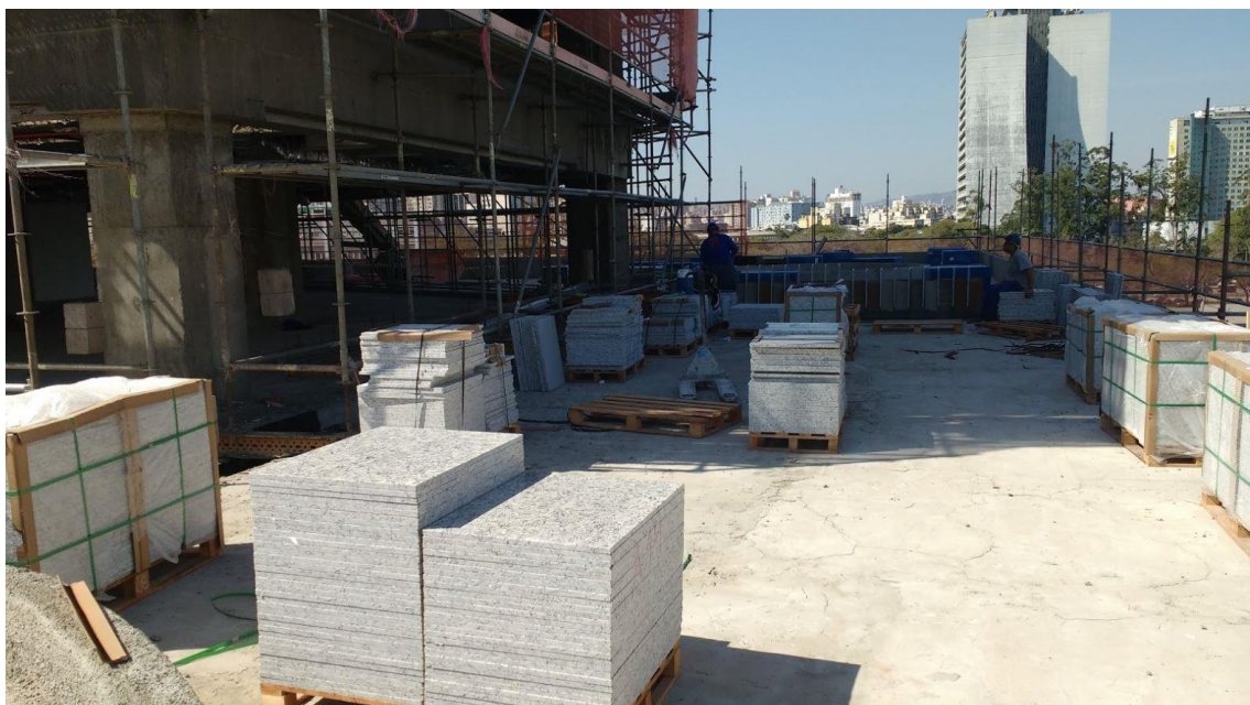
Foto 14: armazenamento do material próximo a aplicação
