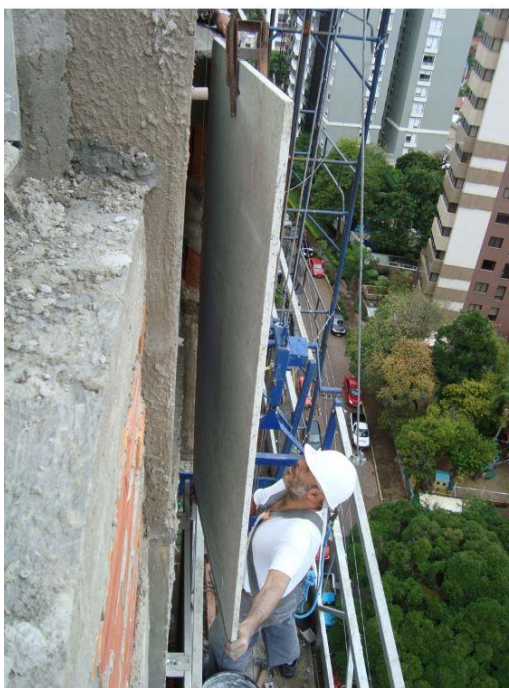
Foto 10: Aplicação de revestimento não aderido, com auxílio da talha 55
