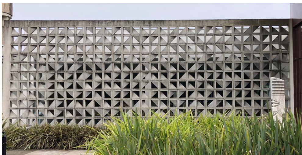
Figura 6: Dispositivo de sombreamento composto de cobogós de concreto
