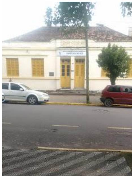
Figura 21: Escola Estadual de Ensino Fundamental Sapucaia Sul
