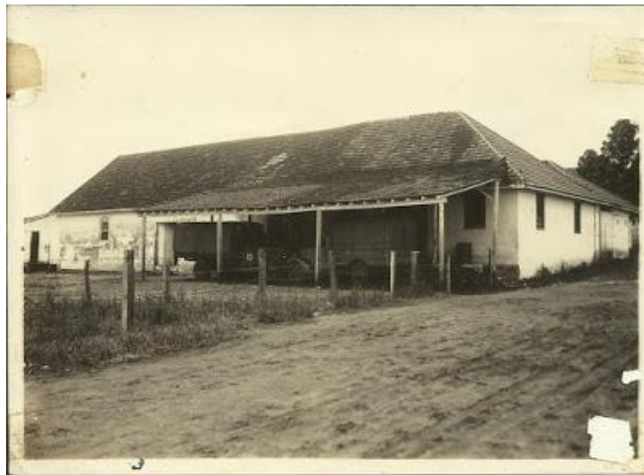
Figura 26: Antigo matadouro – 1930 na Av. Açoriana:
