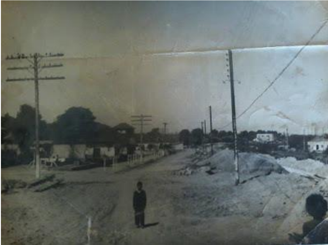
Figura 43: Construção da galeria pluvial – Av. Sapucaia com a Rua Coronel Genuíno
