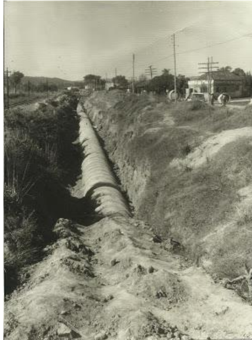
Figura 44: Canalização da Avenida Sapucaia
