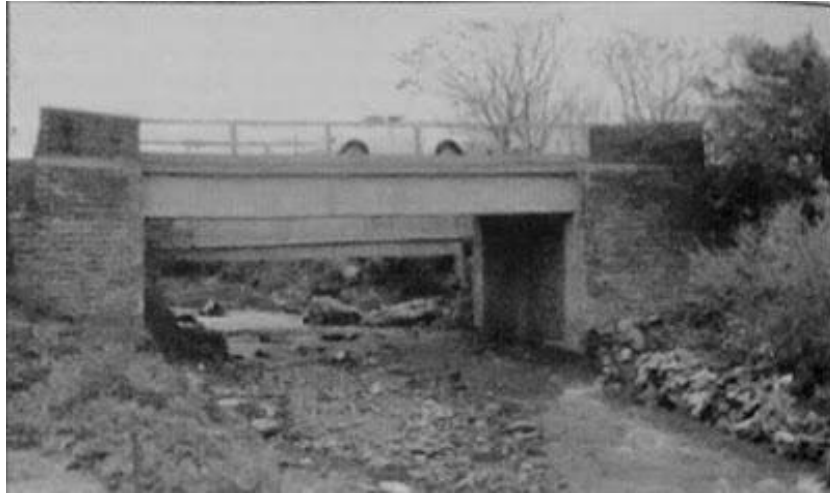
Figura 29: Ponte sobre o arroio José Joaquim- Vila Fortuna – 1984
