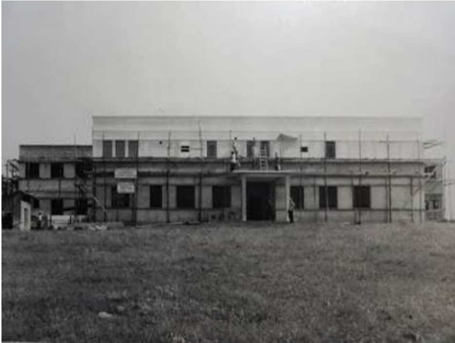
Figura 41: Construção do HMGV
