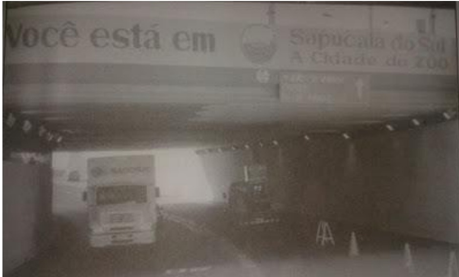
Figura 25: Túnel de Sapucaia do Sul
