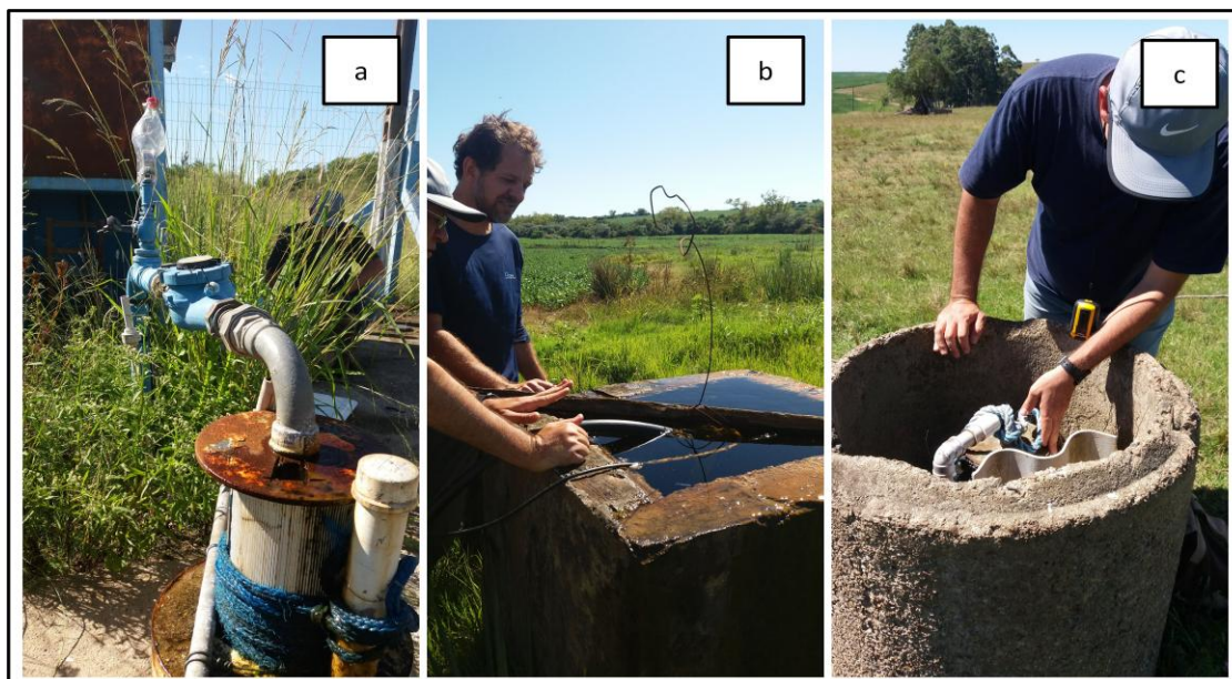
Figura 31. Poços em diversos estados de precariedade foram encontrados. a) Problemas como incrustação ferruginosa. b) Poços com estrutura de cimento que o mantinha submerso. c) Poço protegido por estrutura de cimento aberta que enchia de água, acelerando processos de desgaste dos materiais.
