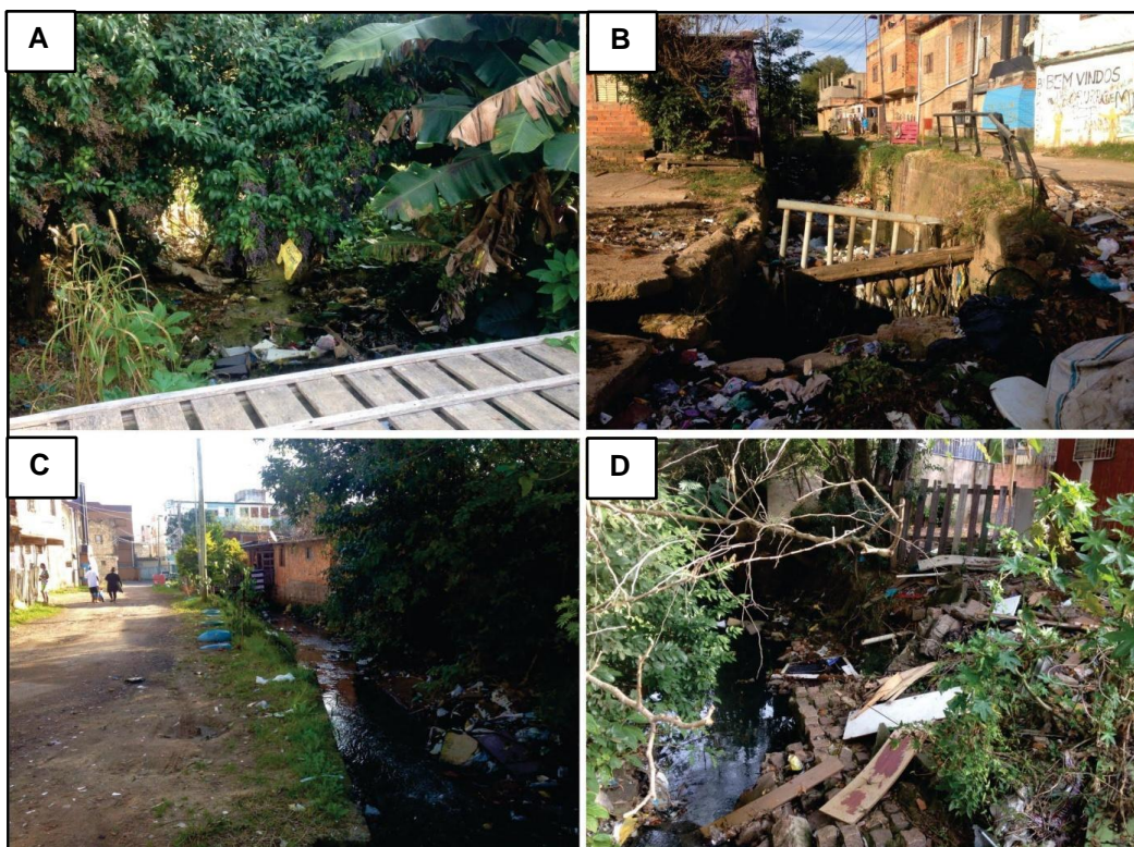
Figura 12 - Trechos de arroios do bairro.
