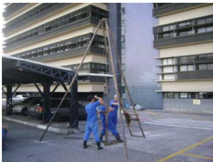
Figura 2 – Execução de sondagem à percussão no local
