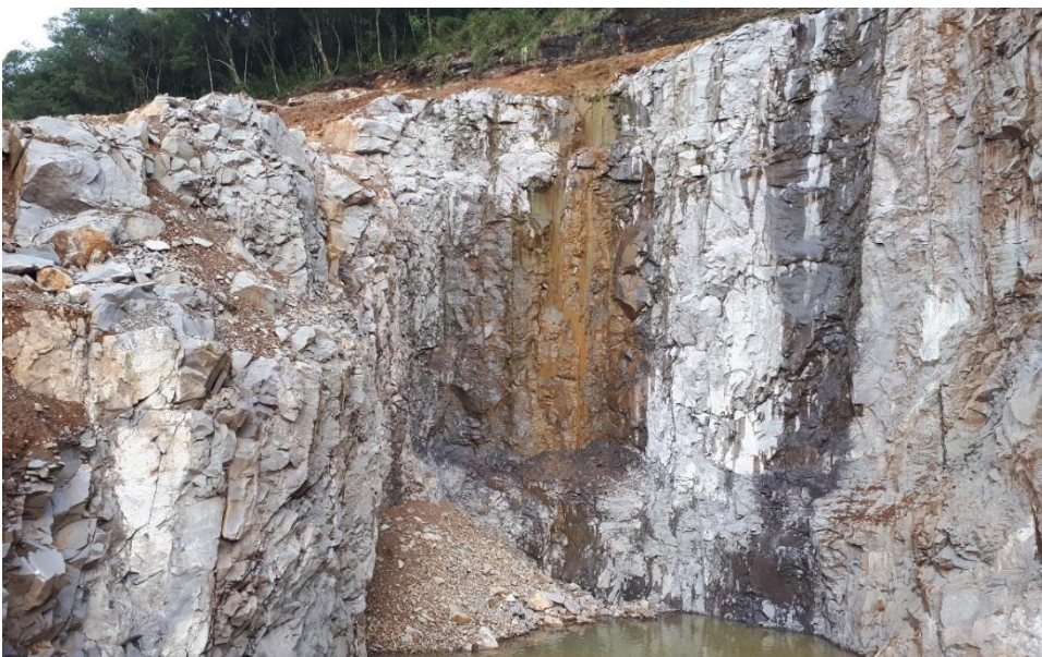
Figura 24. Riodacito com aspecto maciço, baixo grau de fraturamento e com fraturas esparsas cortando o pacote.
