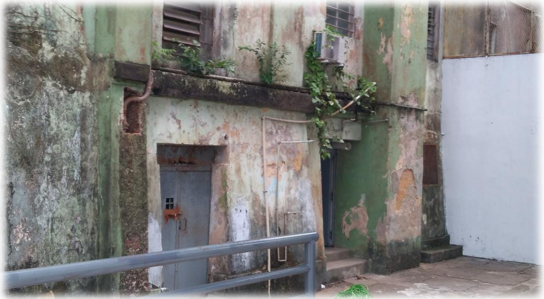
Figura 05: Parte externa de um dos CASE's atendidos por uma das escolas. Na janela de baixo, bem à direita, fica uma das salas da escola.
