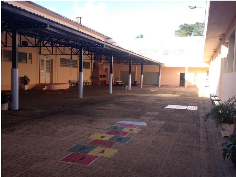
Figura 2. Pátio com cobertura parcial. Porto Alegre, 2018.
