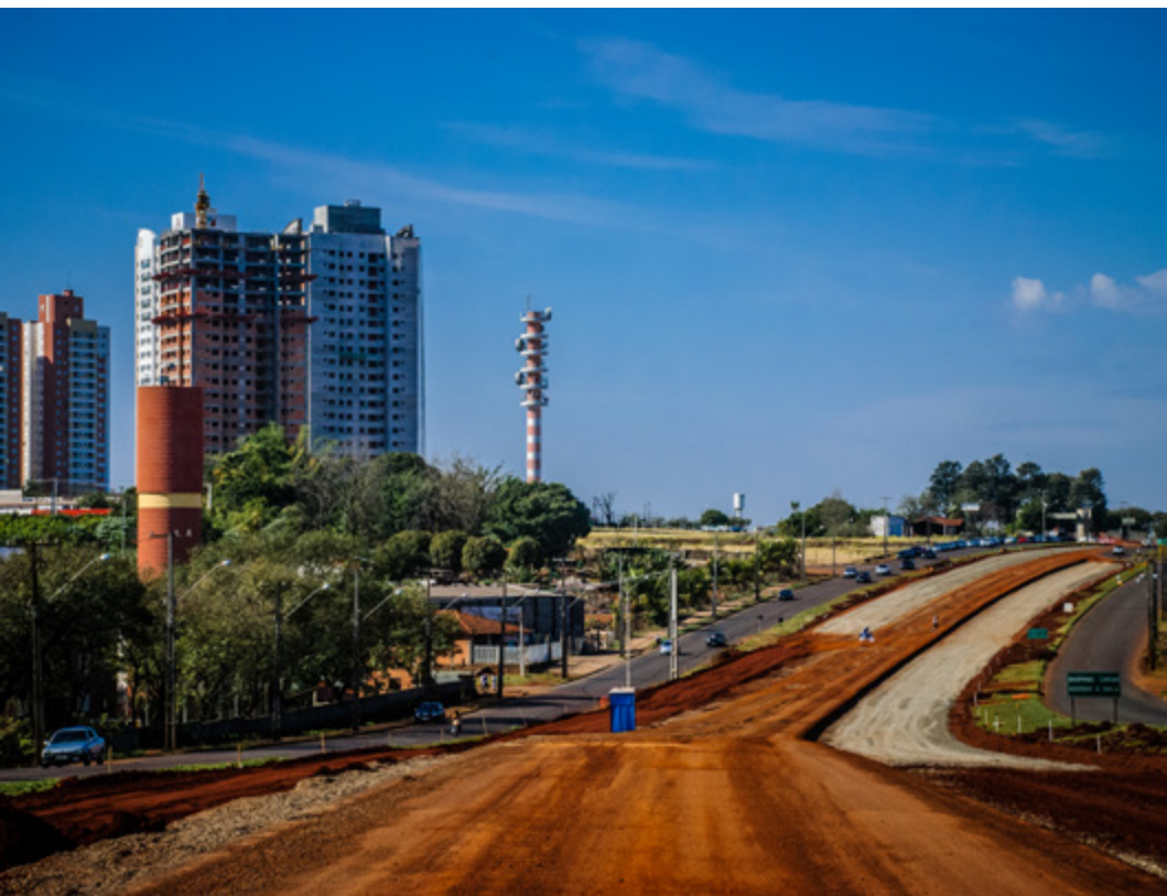
FIGURA 5: Obras de duplicação da PR 445 em 2015
