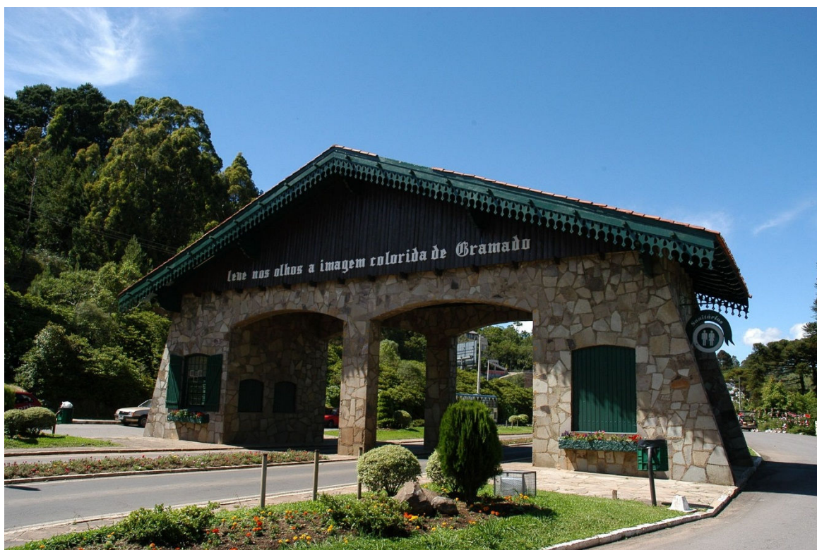
Figura 17 – Pórtico de acesso pela RS235
