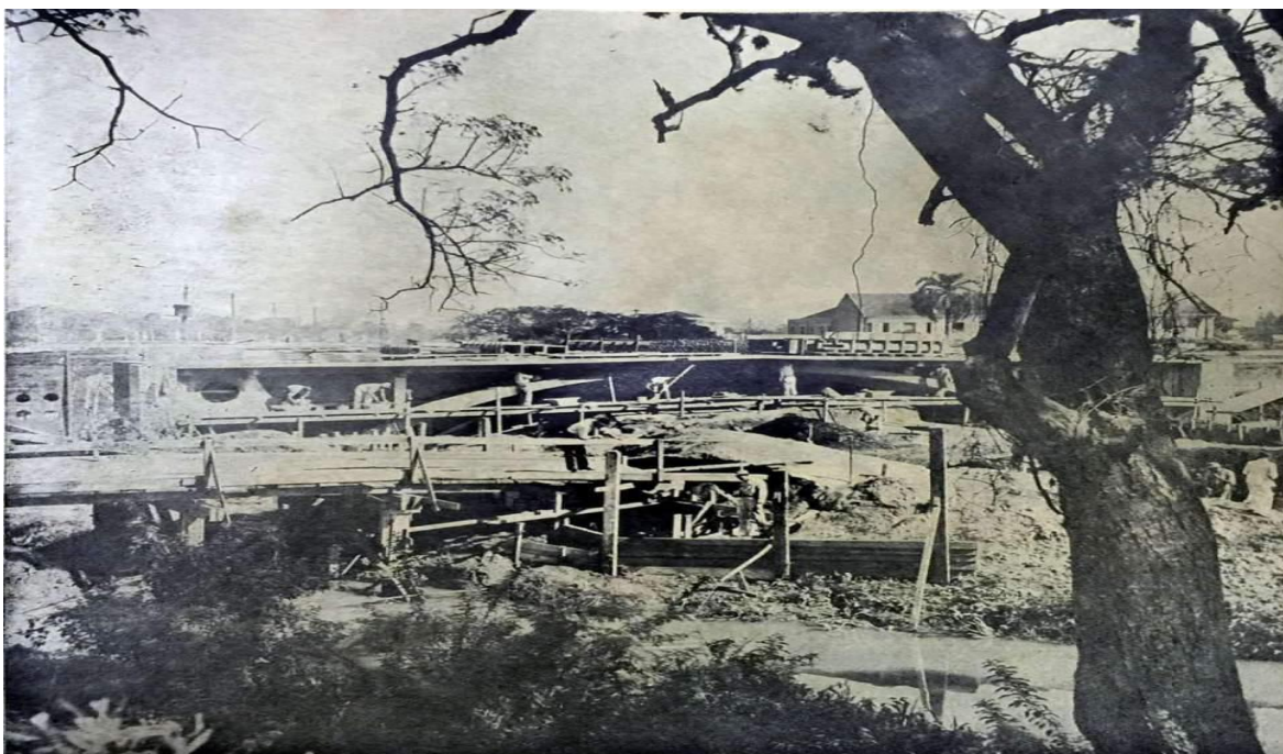
Figura 26 - Construção da ponte sobre Arroio Dilúvio na Avenida Getúlio Vargas na década de 1930. Fonte: Museu Joaquim felizardo, família Prati.
