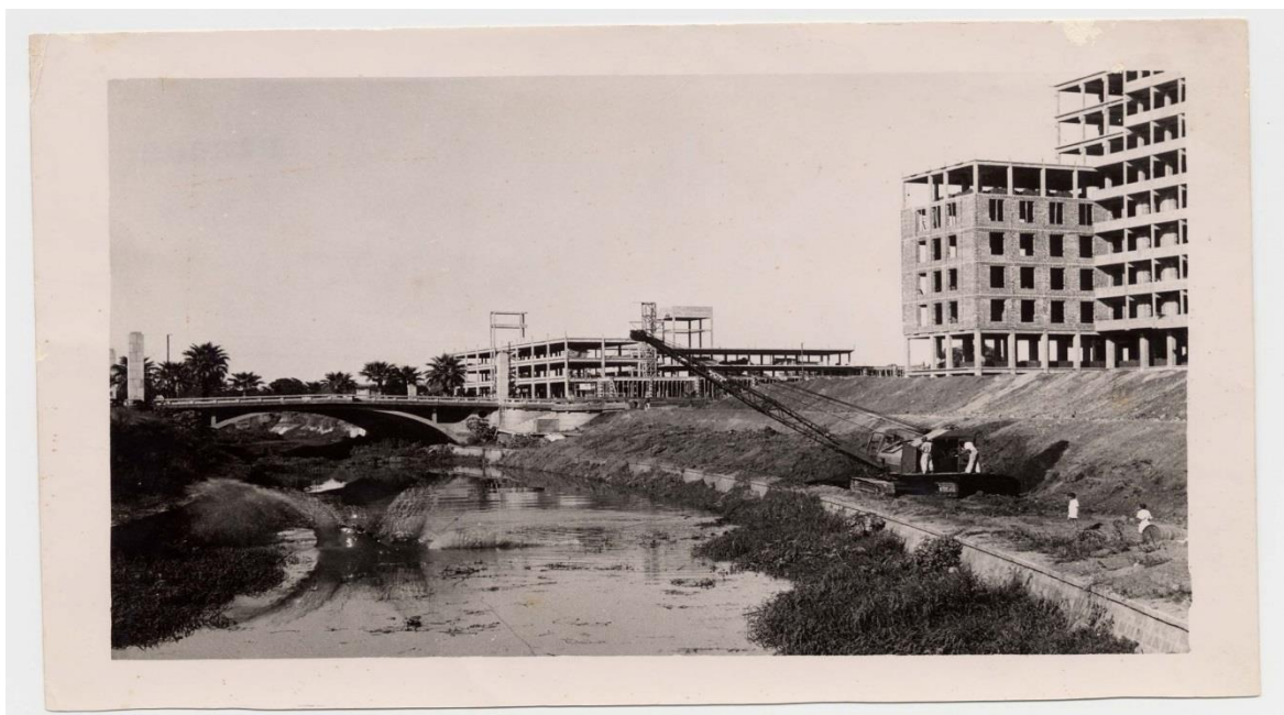
Figura 62 - Obras da canalização do arroio Dilúvio, à direita a construção do Hospital Ernesto Dorneles e do Palácio da Polícia (década de 40), ao fundo a Ponte Av. João Pessoa e suas palmeiras californianas. Fonte: Acervo do Museu Joaquim Felizardo.
