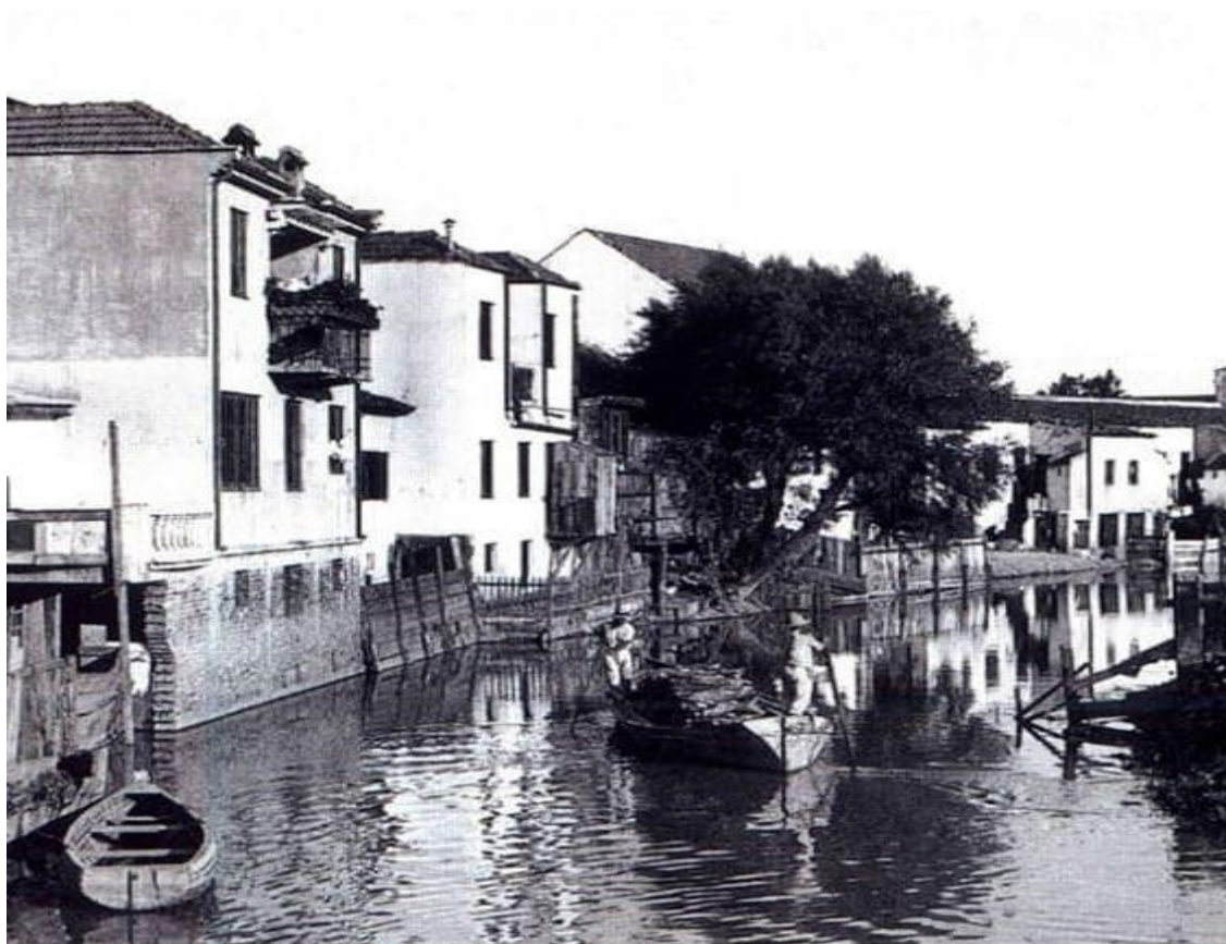
Figura 24 - Arroio Dilúvio em 1928. Observa-se a passagem do arroio nos fundos das casas da Rua João Alfredo. https://gramha.net/explore-hashtag/PortoAlegreAntiga . Acesso: 01/08/2019.
