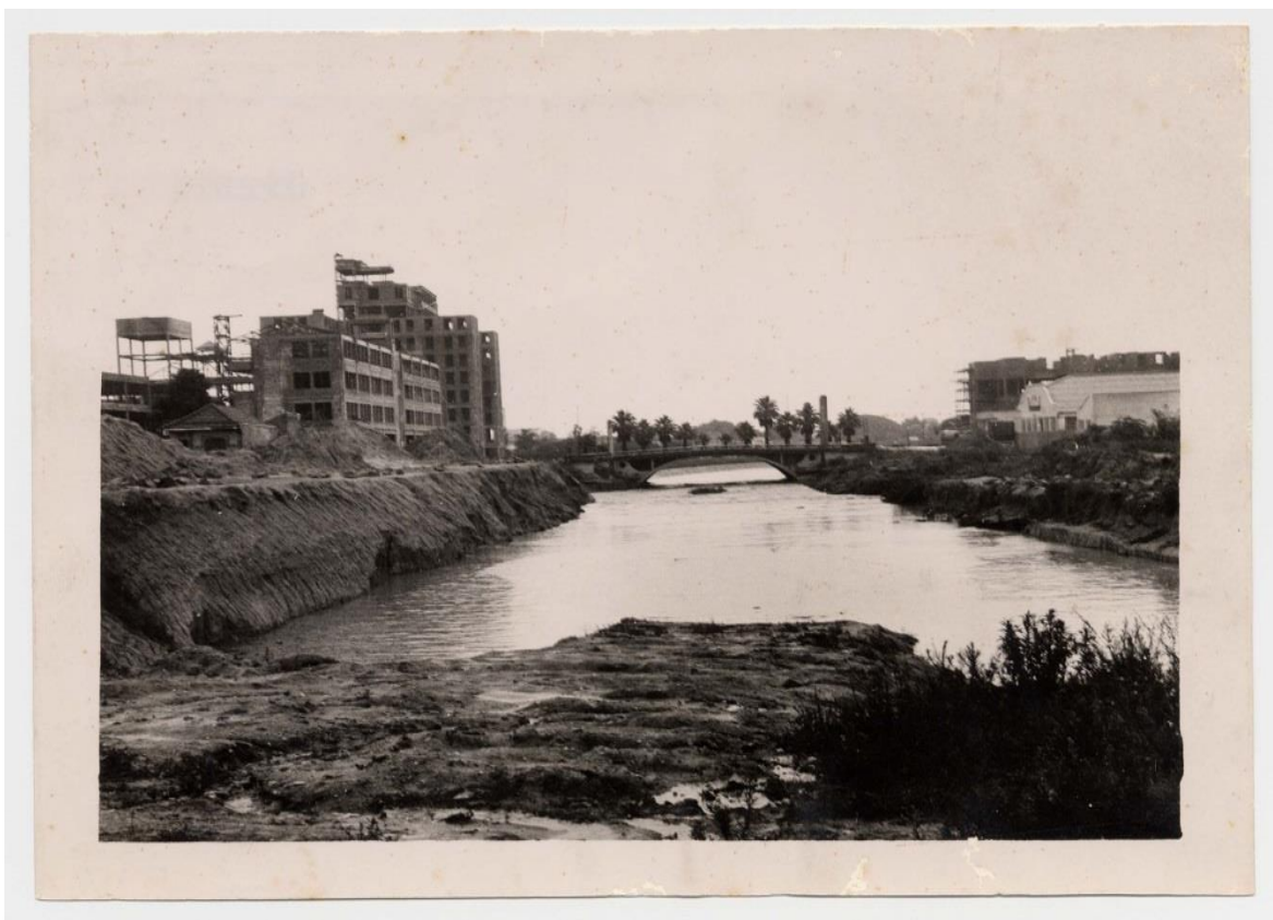
Figura 61 - Obras da canalização do arroio Dilúvio, à esquerda a construção do Palácio da Polícia e do Hospital Ernesto Dorneles (década de 40), ao fundo a Ponte Av. João Pessoa e suas palmeiras. Fonte: Acervo do Museu Joaquim Felizardo.
