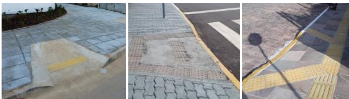
Figura 26 – Imagens de rebaixamento de esquinas
