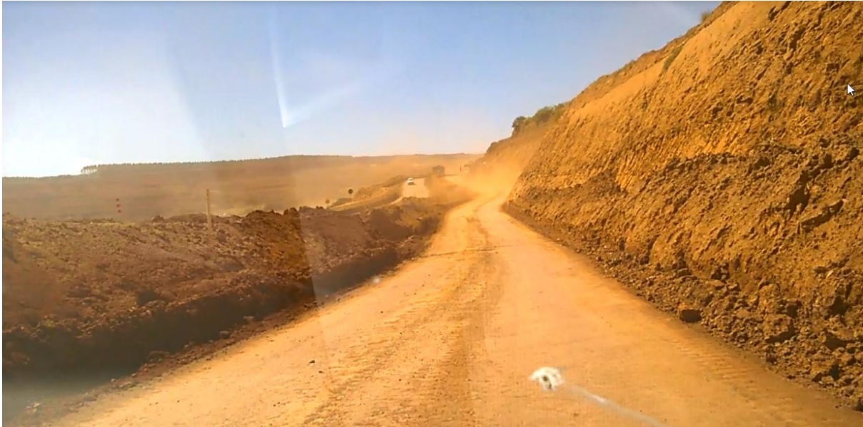
Figura 29. Estrada com berma mediana e sem projeto de drenagem.
