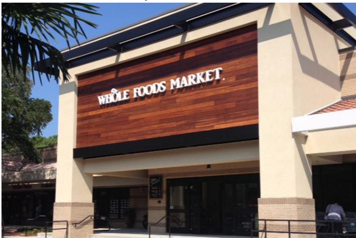
Imagem 15 – Fachada de uma loja de orgânico nos EUA com letreiro branco em fundo de madeira e paredes na cor creme
