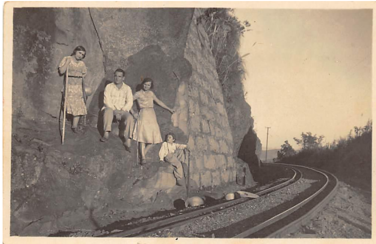
Figura 3 – Construção do trem na localidade em 1920
