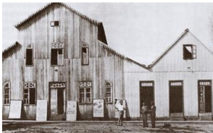
Figura 1 – Fachada do Palácio dos Festivais na época
