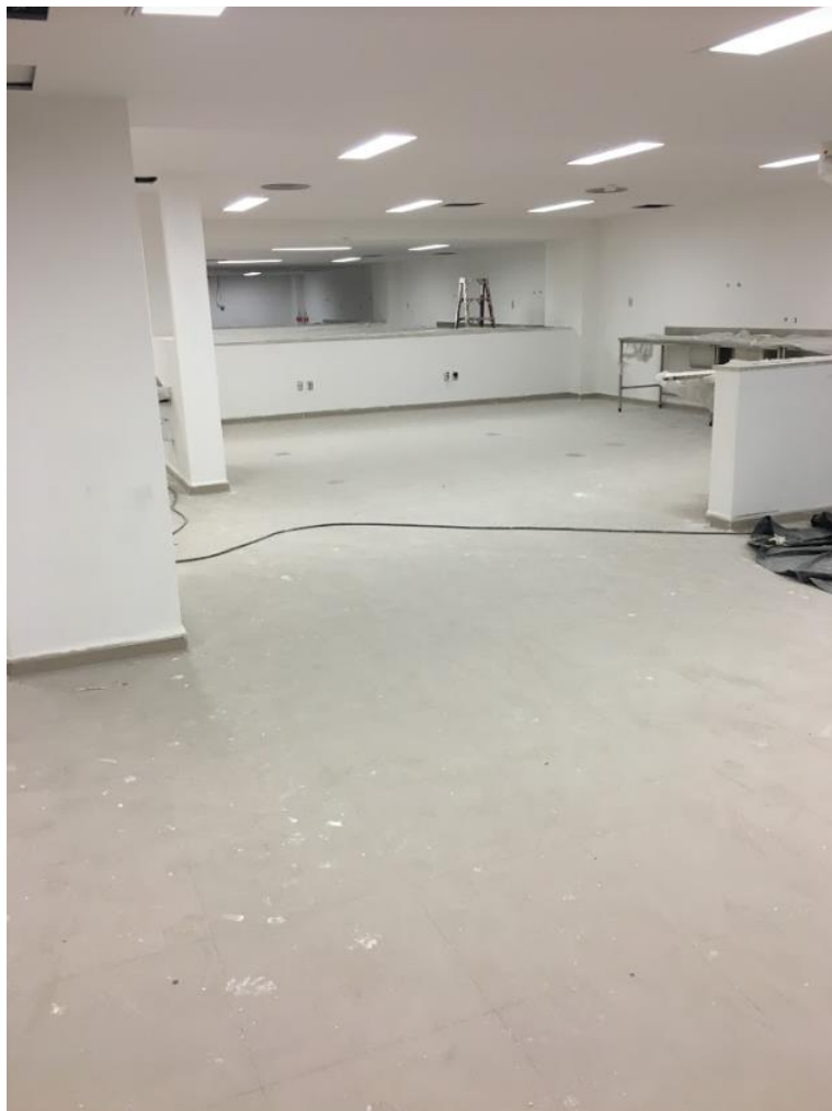
Figura 41: Revestimento de piso cerâmico utilizado na área suja da sala de expurgo
