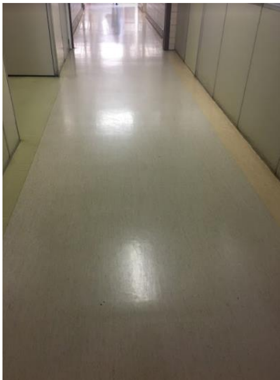
Figura 53: Inexistência de rodapé na circulação horizontal
