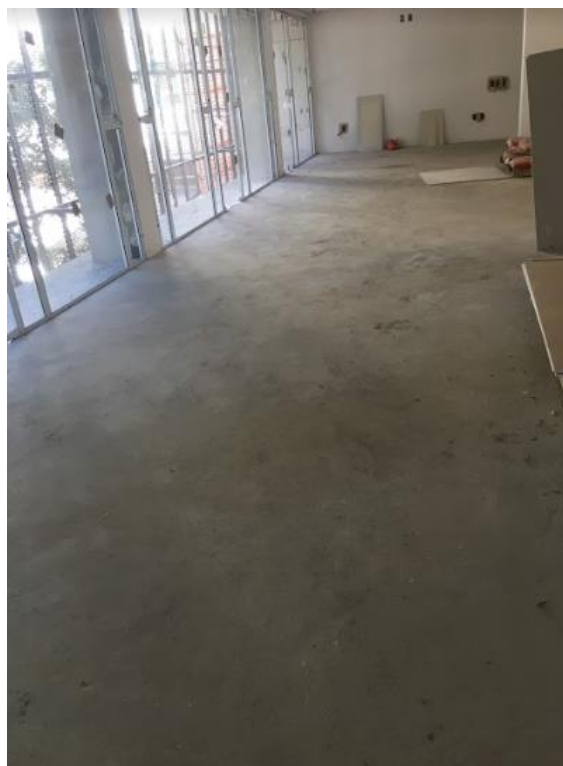
Figura 67: Contrapiso do saguão
