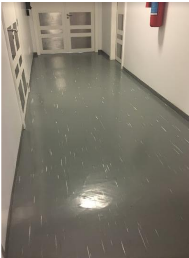
Figura 56: Rodapé em revestimento vinílico em placas inserido em faixas
