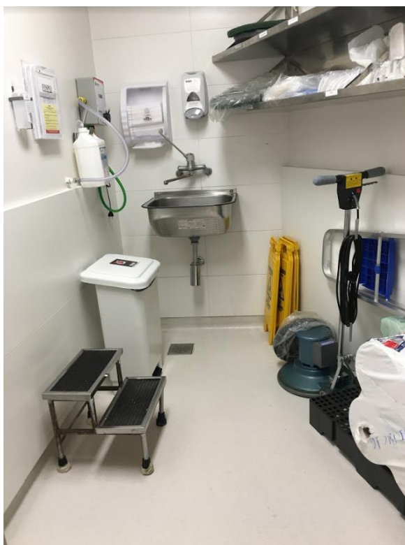
Figura 22: Revestimento de piso vinílico em sala de utilidade
