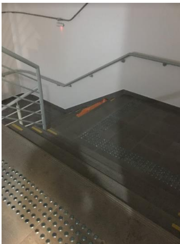
Figura 11: Revestimento de piso em basalto utilizado na caixa de escadas
