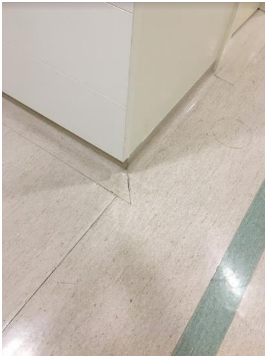
Figura 24: Rodapé arredondado com revestimento de piso vinílico
