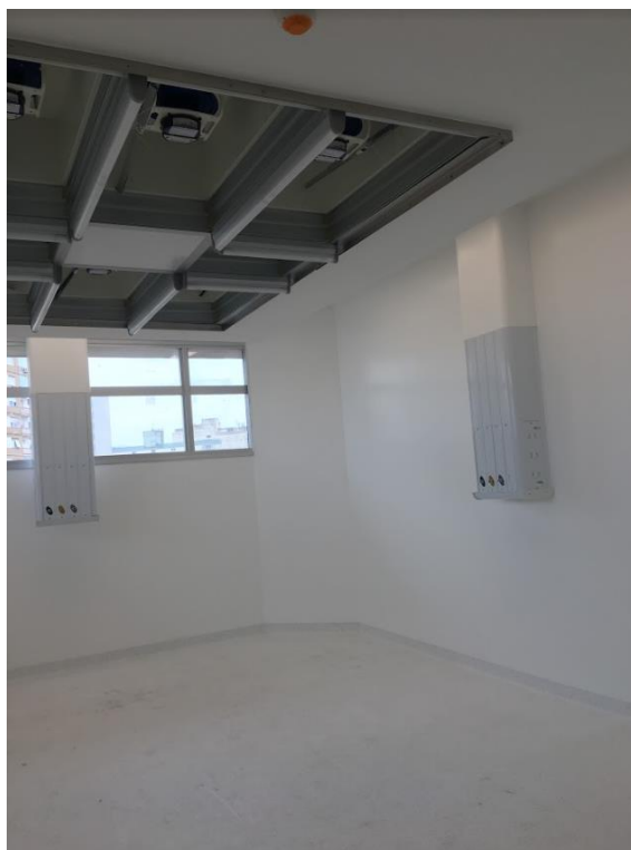
Figura 44: Revestimento de piso vinílico utilizado nas salas de cirurgia
