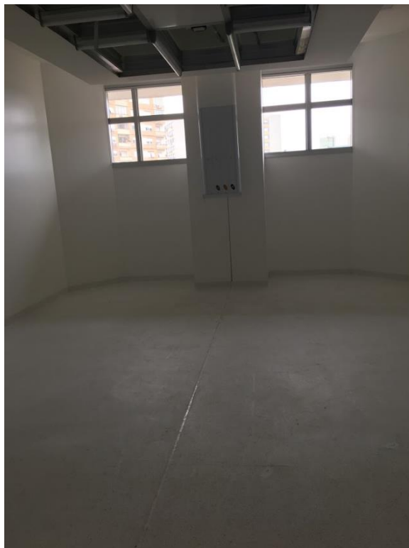
Figura 49: Junta de dilatação estrutural passando pela sala de cirurgia
