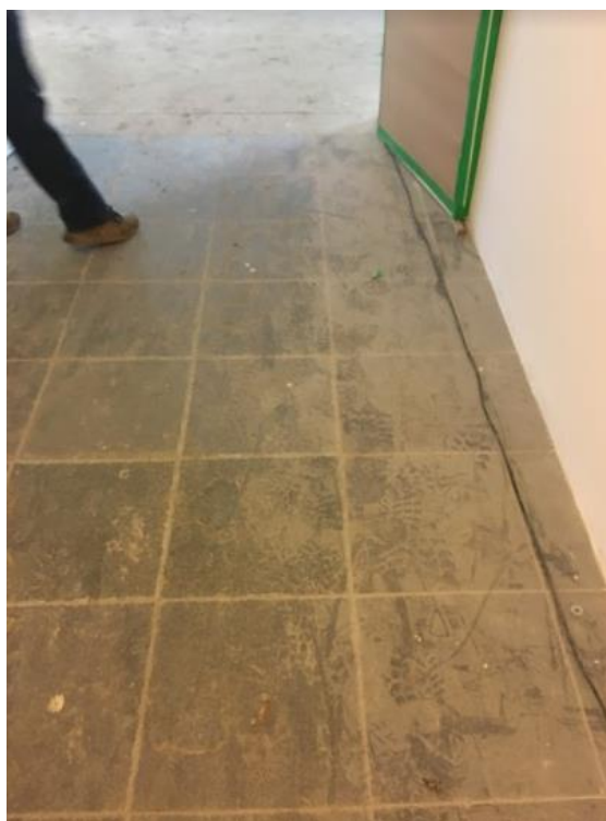
Figura 64: Caixa de escadas com revestimento de piso em basalto
