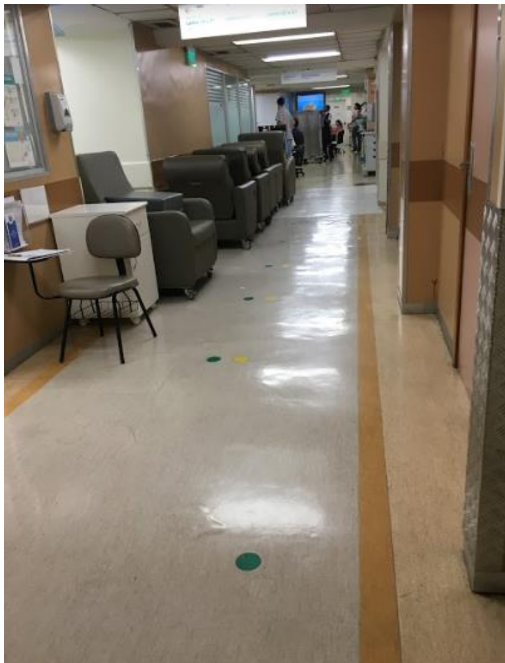
Figura 16: Revestimento de piso vinílico instalado acima de um revestimento cerâmico hexagonal
