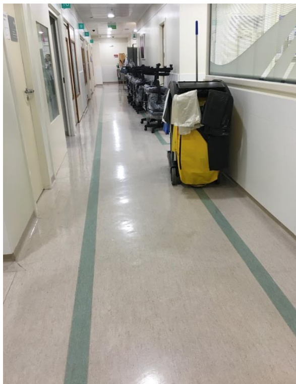
Figura 17: Revestimento de piso vinílico instalado acima do contrapiso
