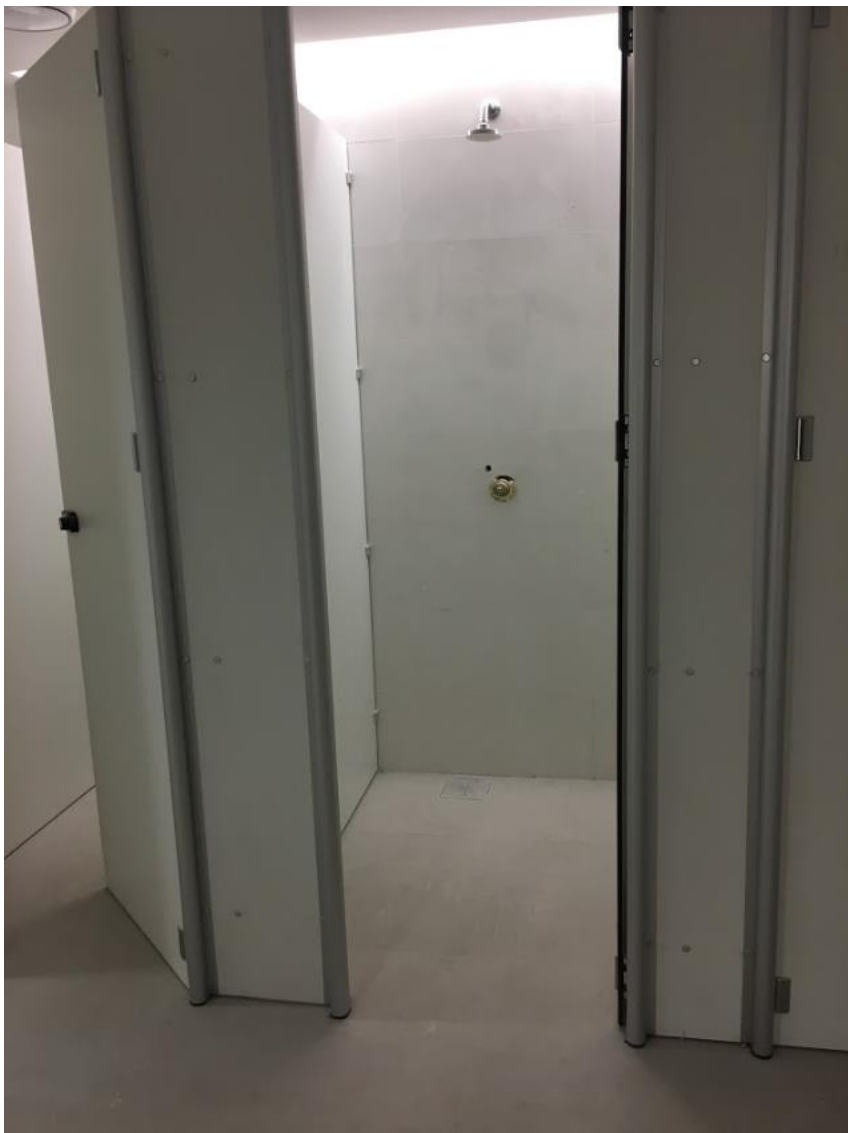
Figura 43: Revestimento de piso cerâmico utilizado nos banheiros
