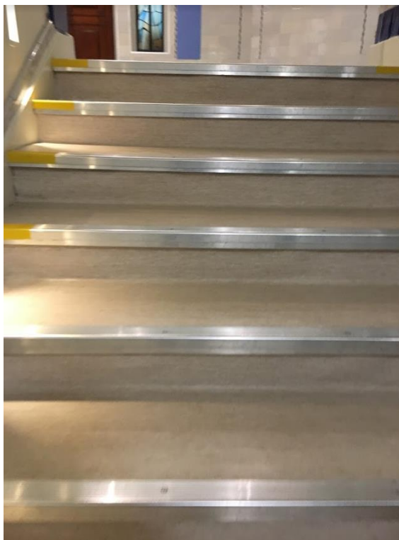
Figura 12: Revestimento de piso vinílico utilizado na caixa de escadas
