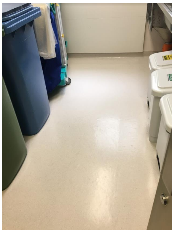
Figura 23: Revestimento de piso vinílico em sala para guarda de resíduos
