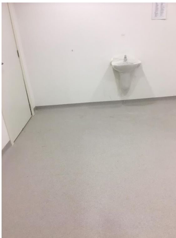
Figura 36: Área operacional com revestimento de piso vinílico
