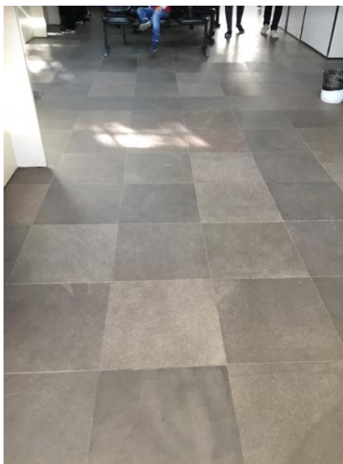
Figura 70: Revestimento de piso em basalto utilizado na área de recepção
