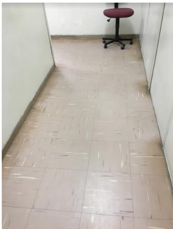
Figura 75: Rodapés em madeira e em alguns locais, inexistentes
