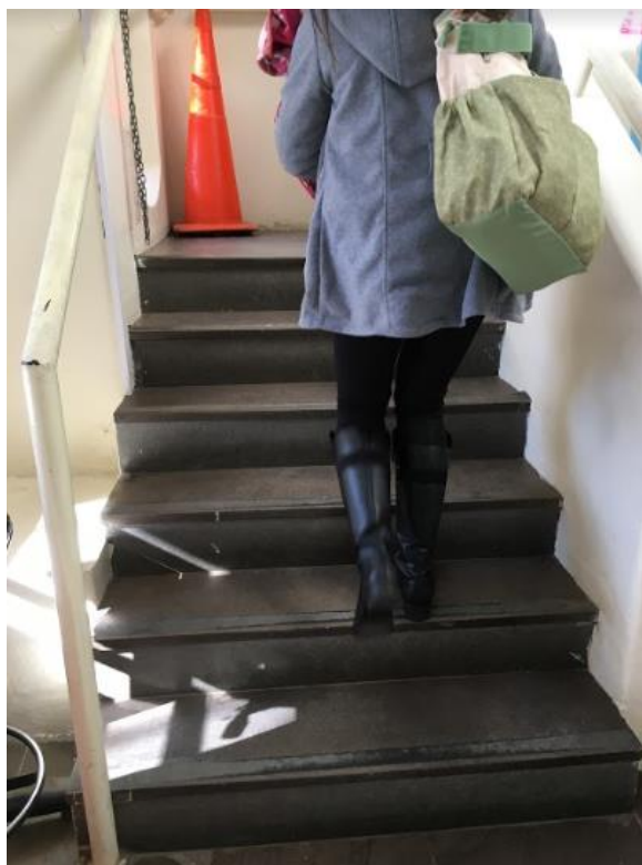
Figura 71: Revestimento de piso em basalto utilizado na circulação vertical
