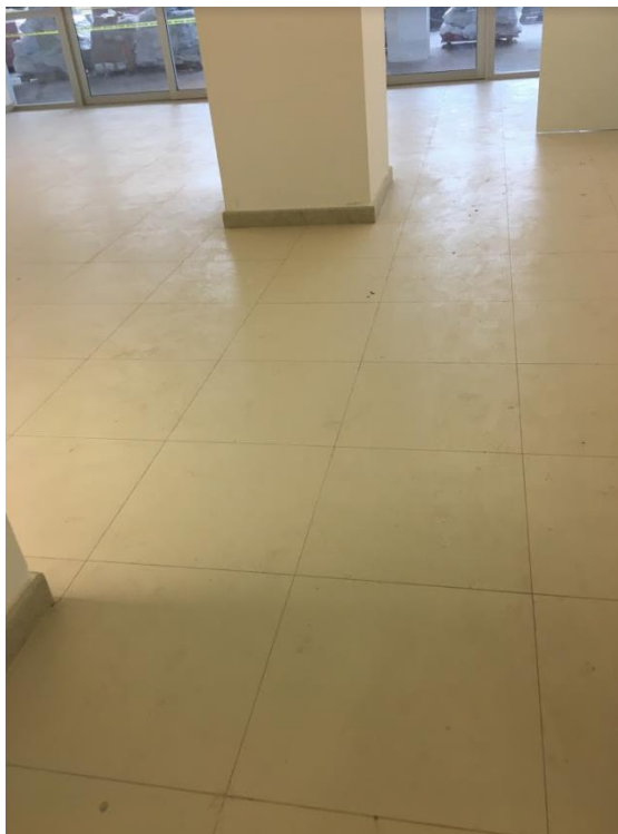
Figura 33: Revestimento de piso cerâmico utilizado na área de recepção
