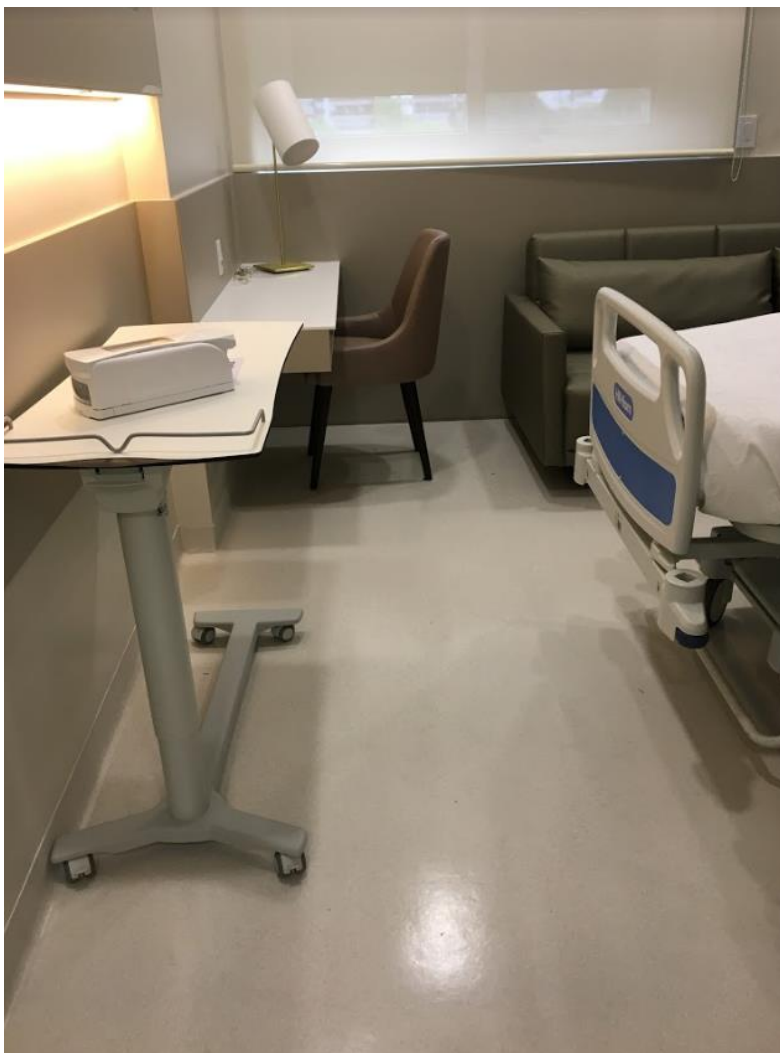
Figura 19: Revestimento de piso vinílico em dormitório de paciente
