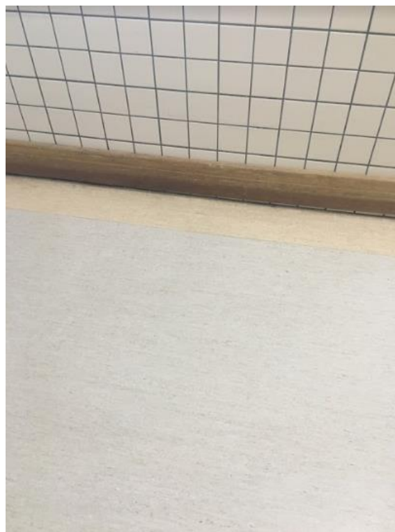
Figura 54: Rodapé em madeira na circulação
