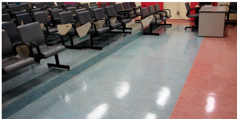
Figura 6: Revestimento de piso granilite
