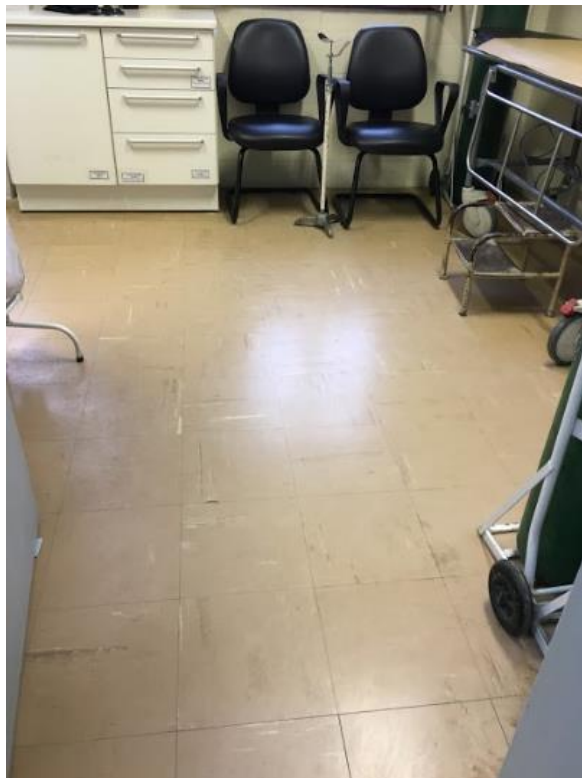
Figura 76: Revestimento de piso vinílico em placas utilizado em área de operação
