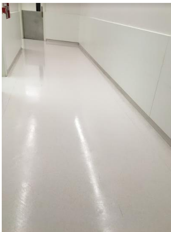
Figura 18: Revestimento de piso vinílico instalado acima do contrapiso alisado
