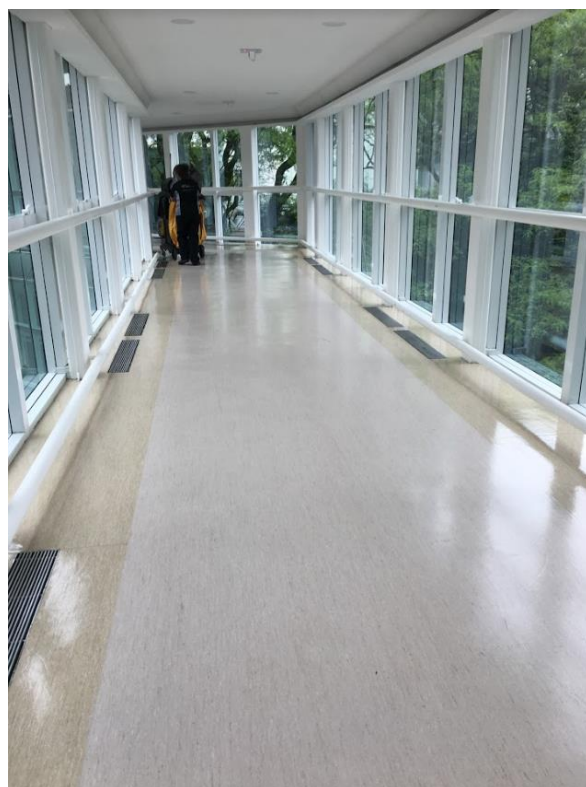
Figura 21: Revestimento de piso vinílico em passarela
