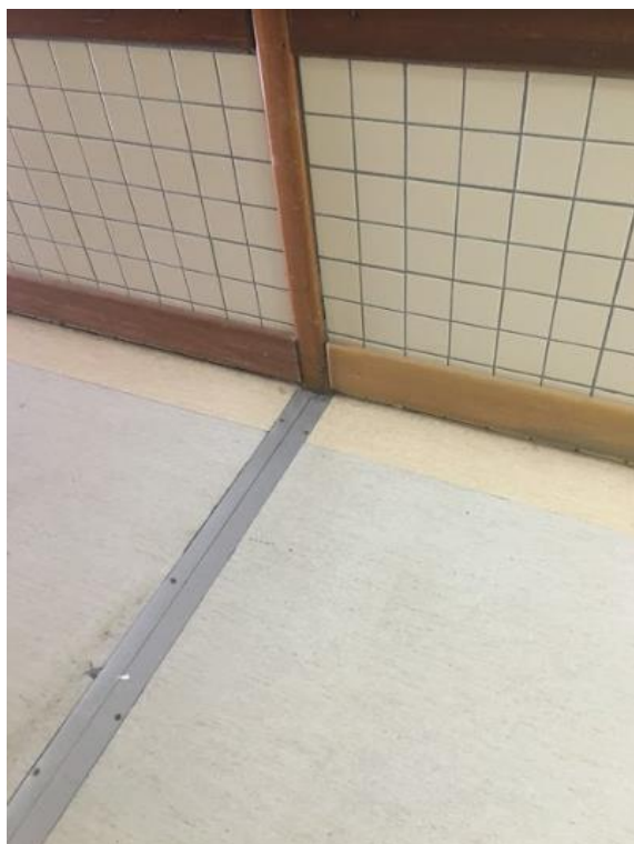
Figura 57: Junta de dilatação estrutural
