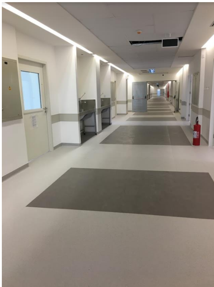
Figura 38: Revestimento de piso vinílico utilizado na circulação, utilizando-se de duas cores para demarcação de portas
