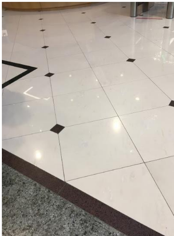
Figura 8: Revestimento de piso cerâmico utilizado na recepção
