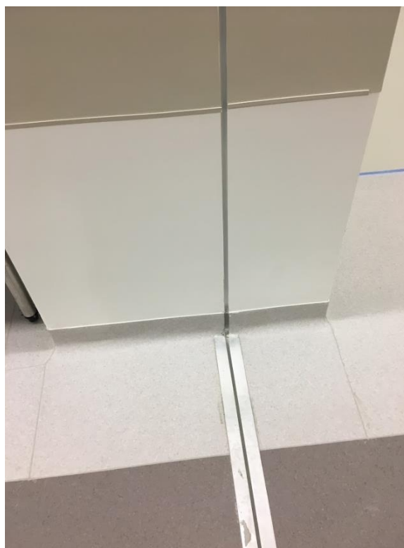
Figura 48: Junta de dilatação estrutural passando pela área de circulação
