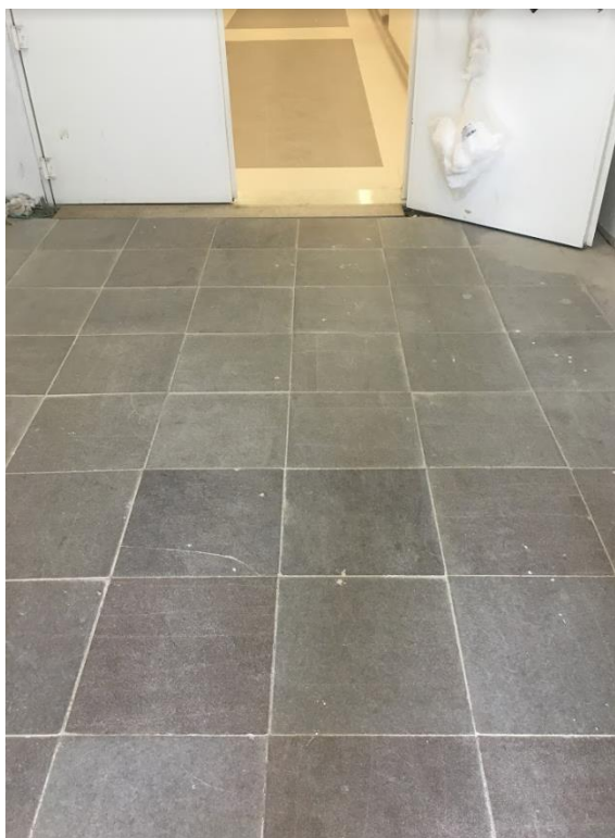
Figura 34: Revestimento de piso em basalto utilizado no acesso à circulação vertical
