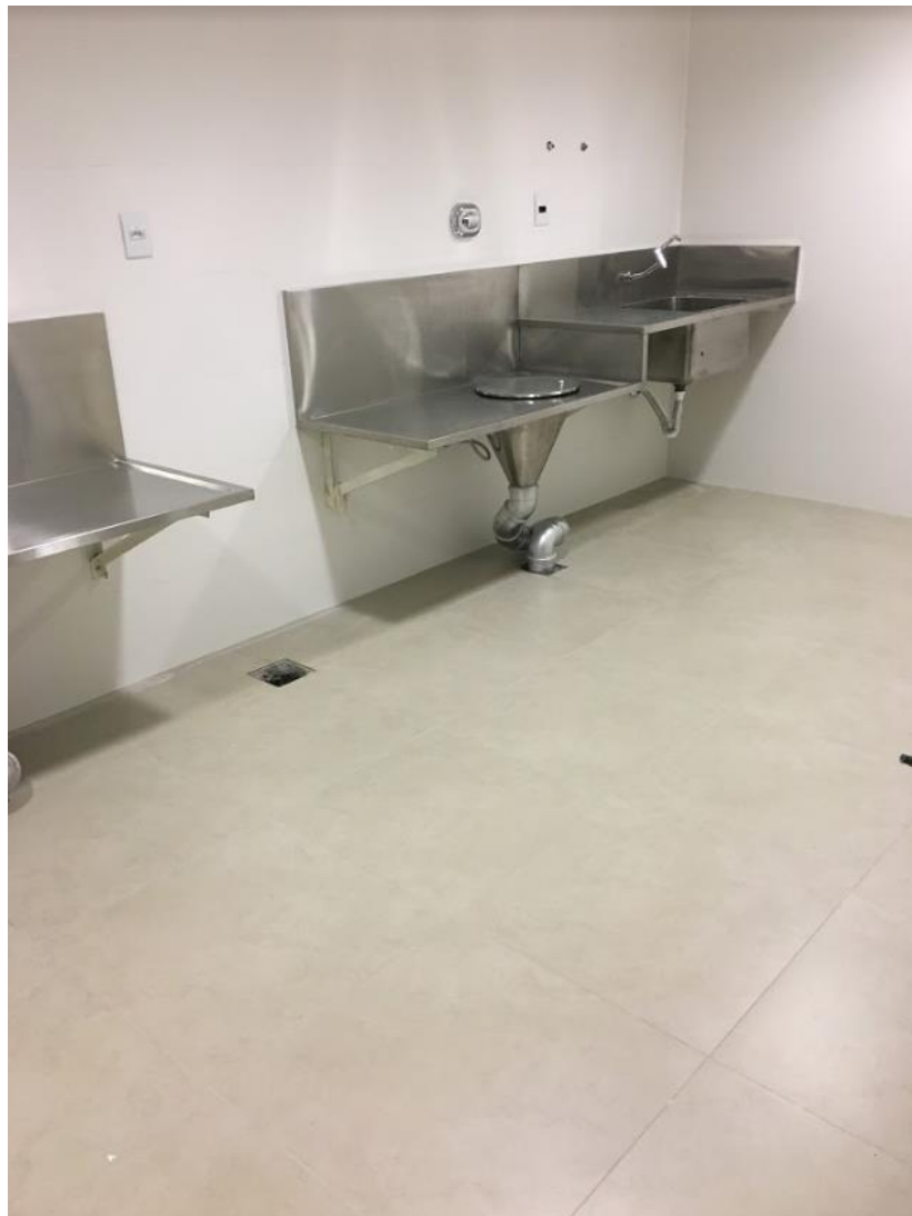
Figura 35: Área operacional com revestimento de piso cerâmico
