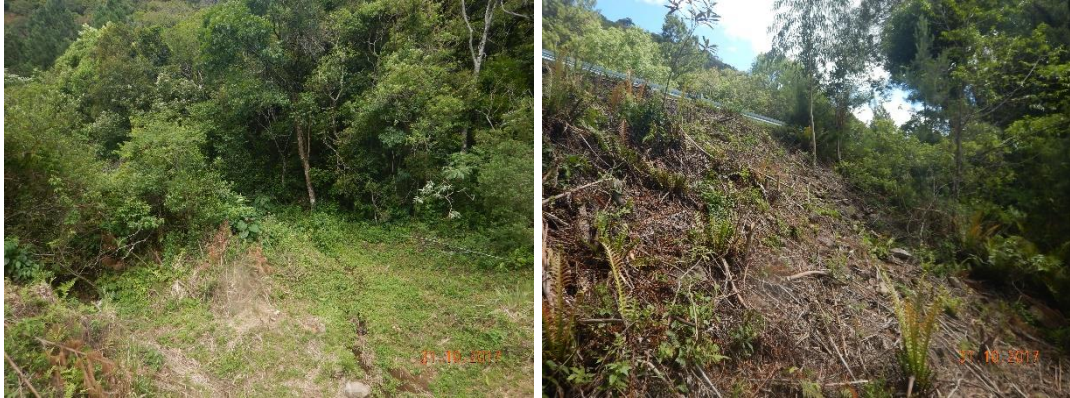
Figura 5: Vista geral da lateral de montante da rodovia (esquerda) e vista do aterro (direita)
