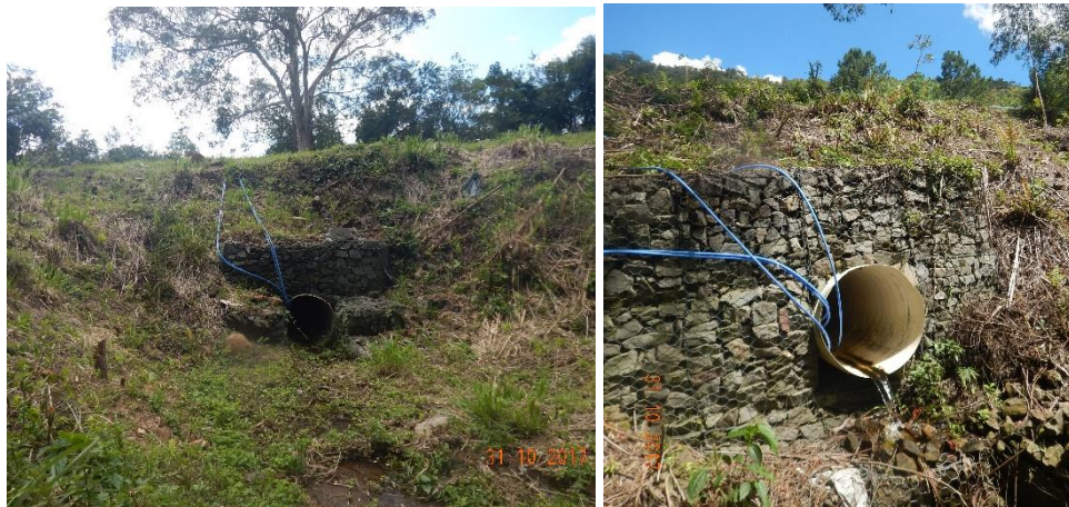
Figura 6: Vista da entrada do bueiro (esquerda) e vista da saída do bueiro (direita)
