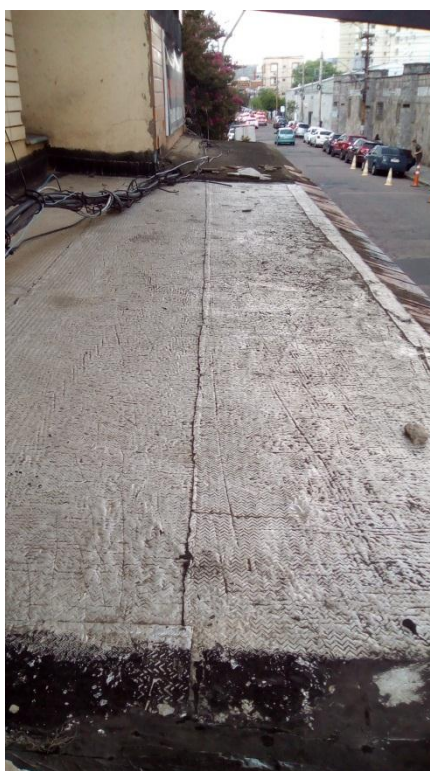
Figura 55 – Região B impermeabilizada com manta asfáltica aluminizada
