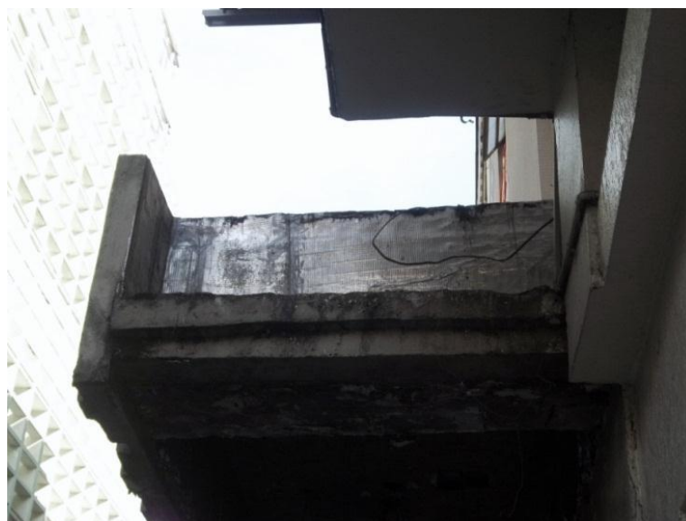
Figura 28 – Lateral da marquise 1 com manta asfáltica aluminizada aparente
