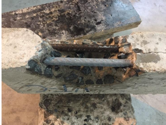
Figura 42 – Exemplo de recuperação do concreto degradado e passivação da armadura
