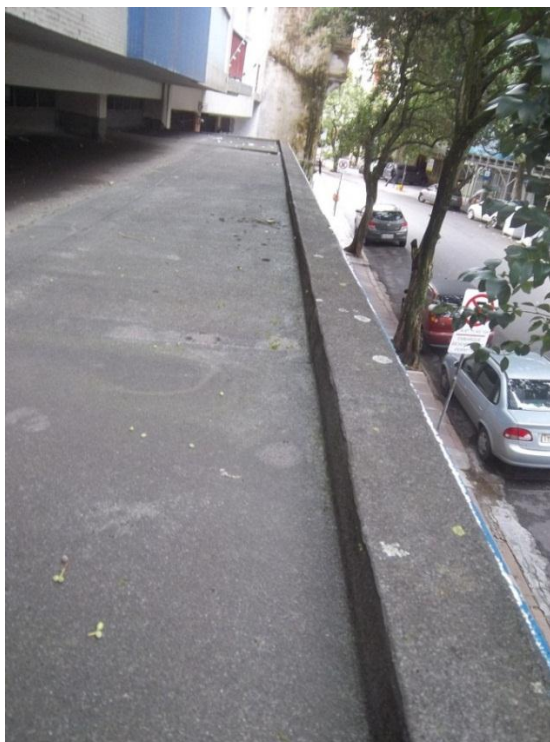
Figura 110 – Ressaltos de bordo do lado superior da marquise 4
