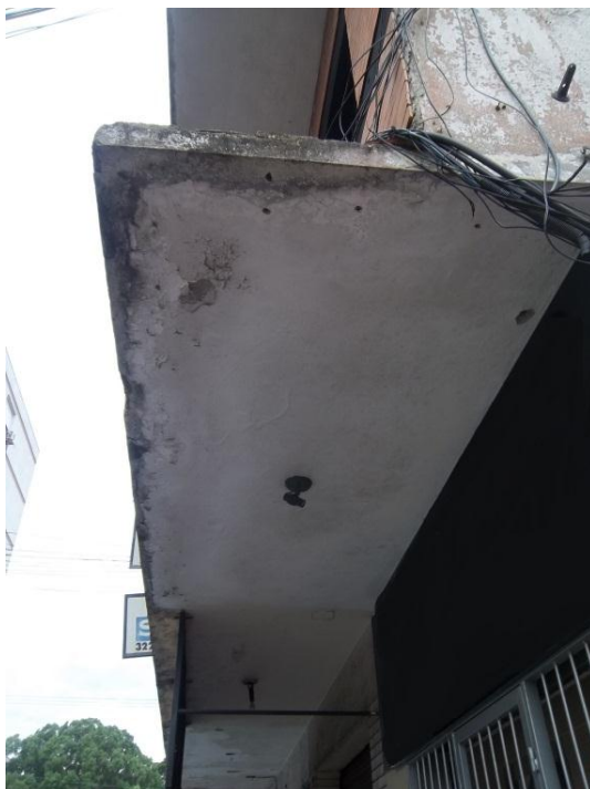
Figura 69 – Manifestações Patológicas na parte inferior da região A
