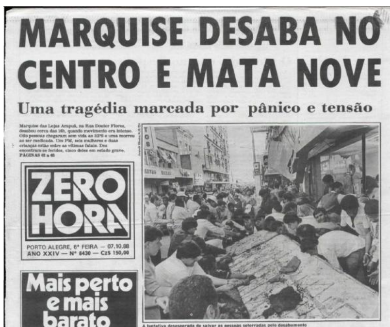
Figura 17 – Acidente com queda de marquise da loja Arapuã
