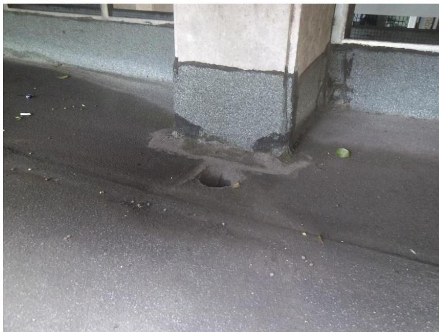
Figura 114 – Detalhe do duto para escoamento das águas pluviais
