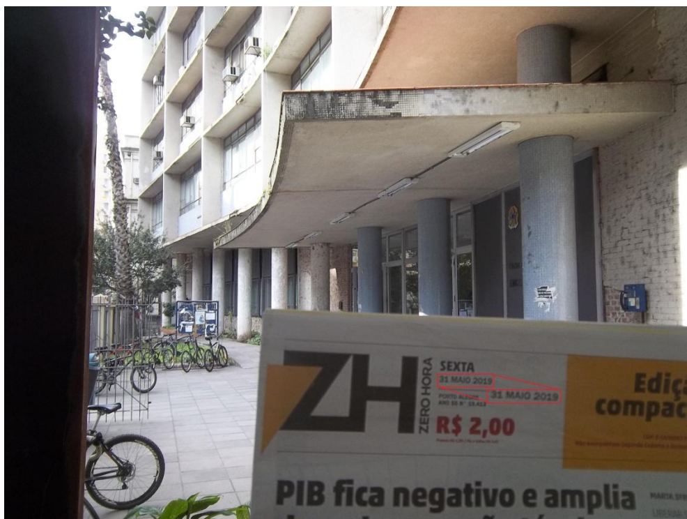
Figura 85 – Comprovação da data da última vistoria realizada na marquise 3
