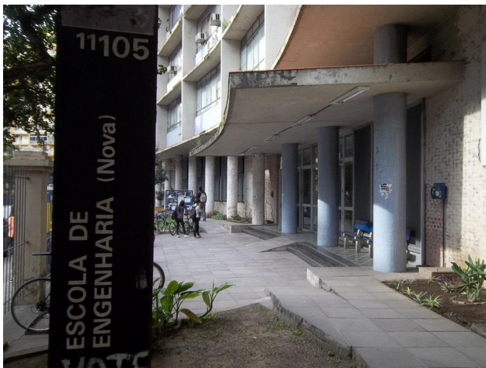
Figura 84 – Fachada do prédio “novo” da Engenharia da UFRGS com evidência para a marquise
