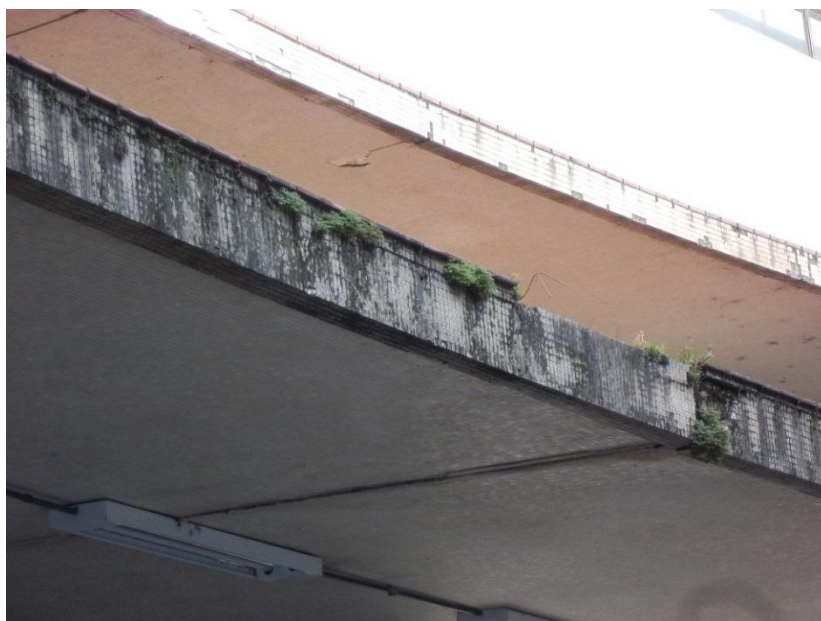
Figura 95 – Presença de vegetação no espelho da marquise
