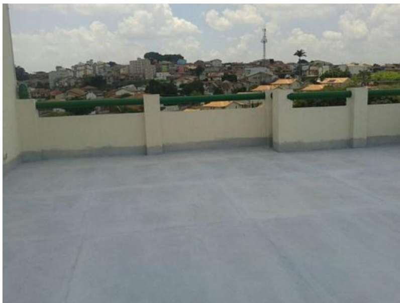
Figura 13 – Exemplo de aplicação da argamassa polimérica
