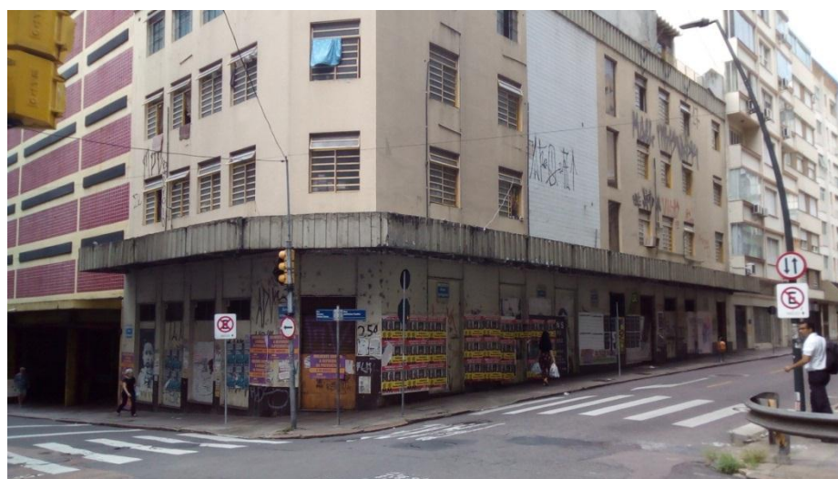
Figura 22 – Fachada da edificação da marquise 1
