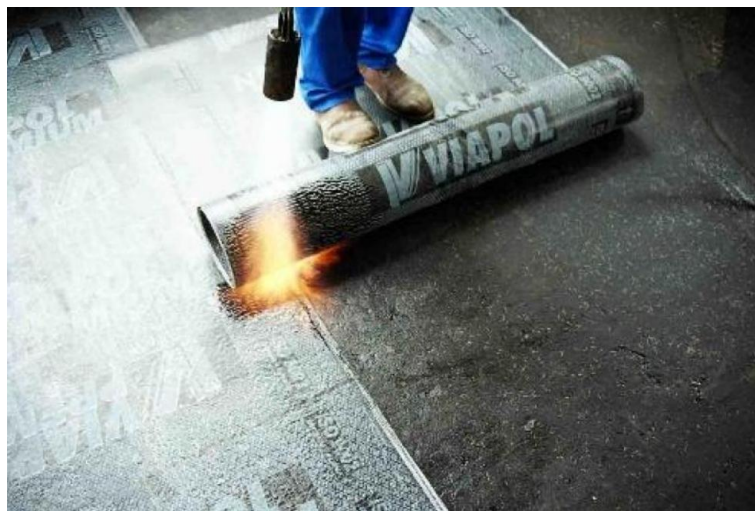
Figura 7 – Aplicação de manta asfáltica com maçarico sobre base imprimada
