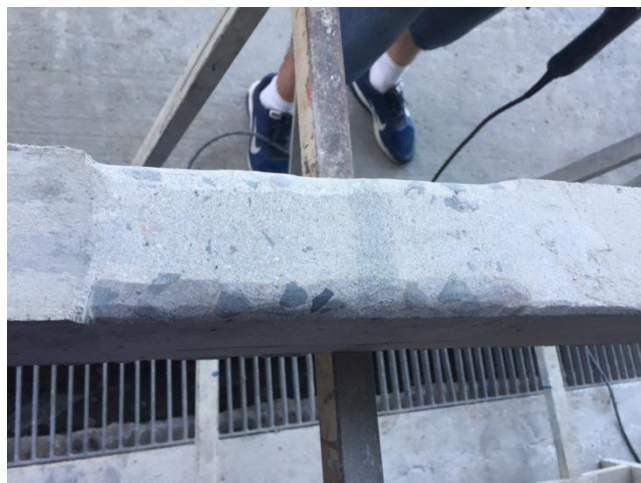
Figura 43 – Arredondamento das quinas para colagem da fibra de carbono
