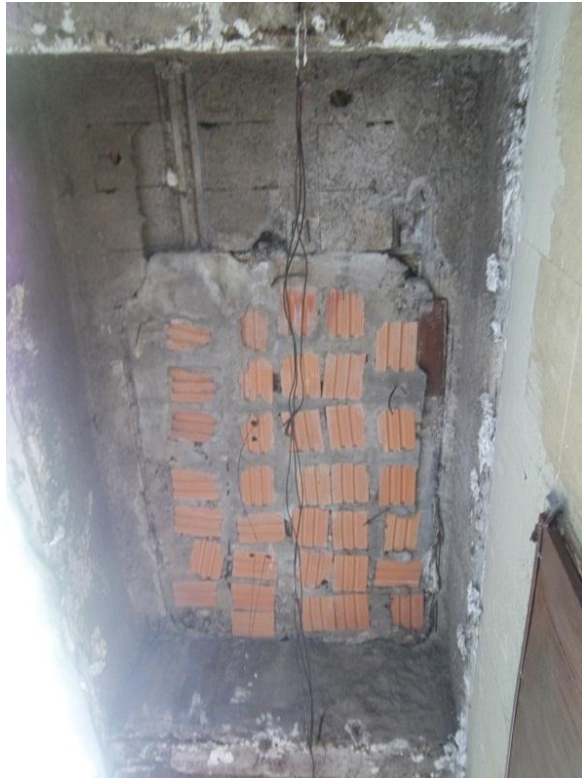
Figura 33 – Remendos na laje L5
