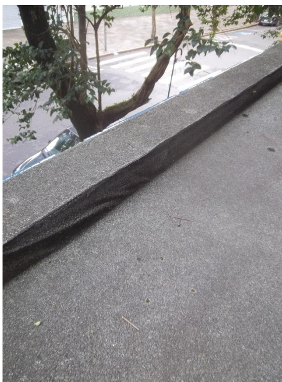
Figura 113 – Detalhe da execução da manta asfáltica no ressalto de bordo da marquise 4
