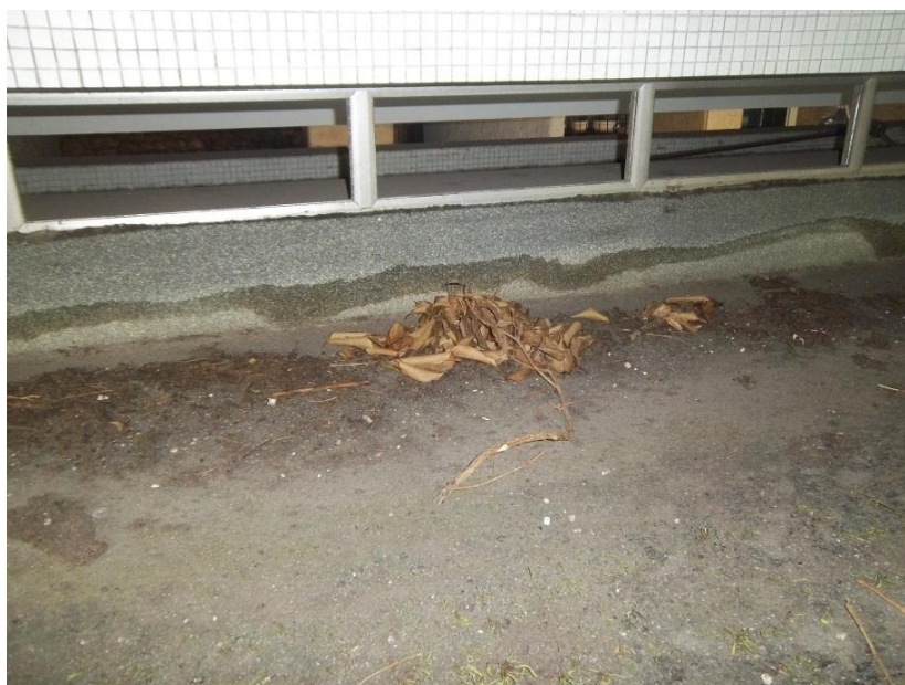
Figura 117 – Folhas secas depositadas próximo ao engaste
