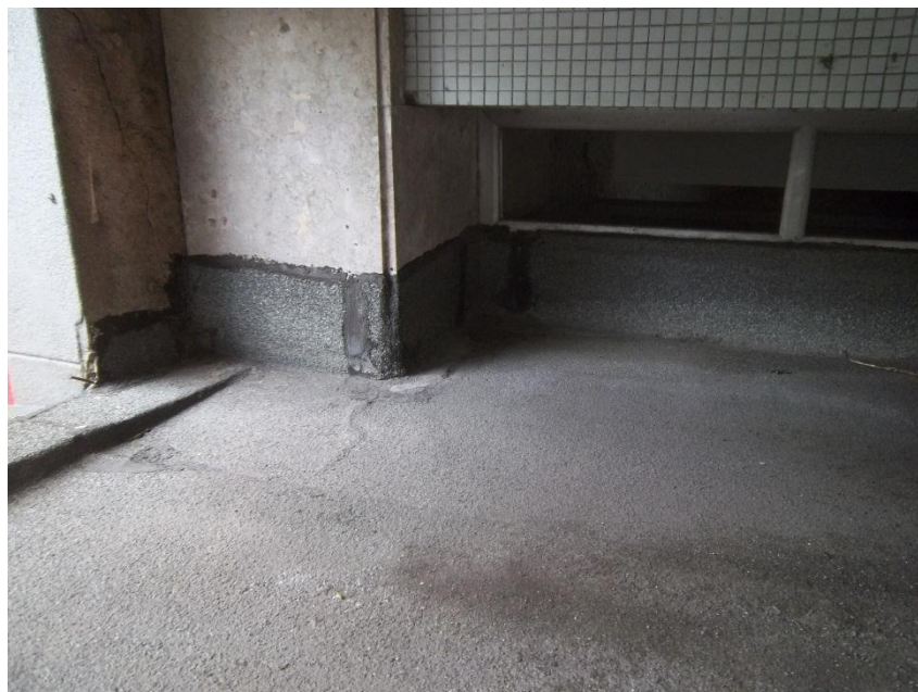
Figura 112 – Detalhe da execução da manta asfáltica no engaste da marquise 4
