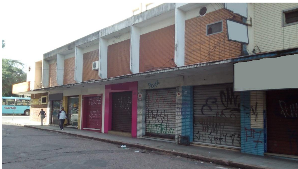
Figura 49 – Uma das fachadas da edificação da marquise 2
