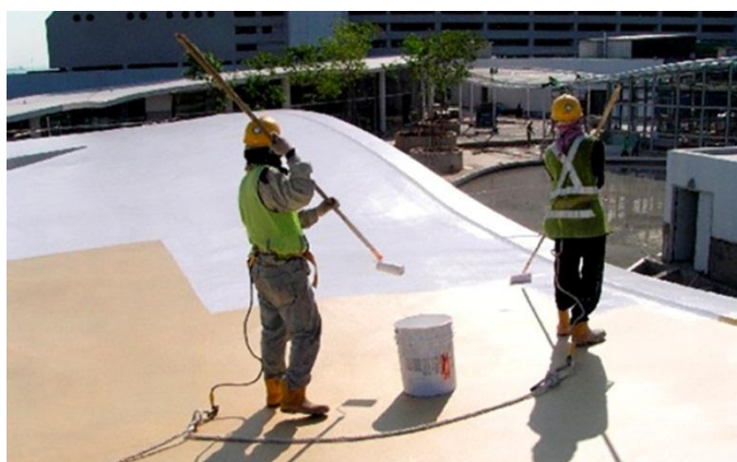
Figura 12 – Exemplo de utilização de membrana acrílica
