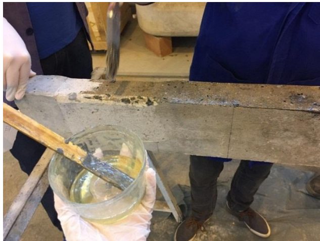
Figura 44 – Exemplo de aplicação de primer
