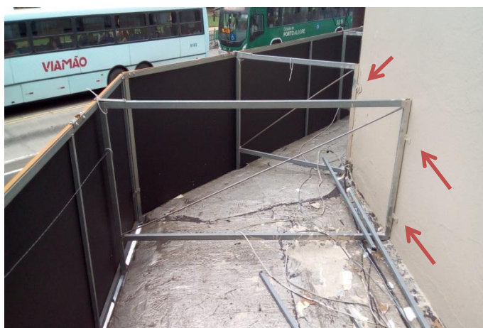
Figura 81 – Letreiro fixado na fachada da edificação
