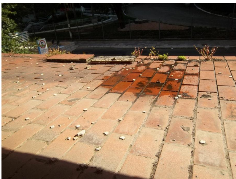
Figura 91 – Gotejamento do dreno do ar condicionado
