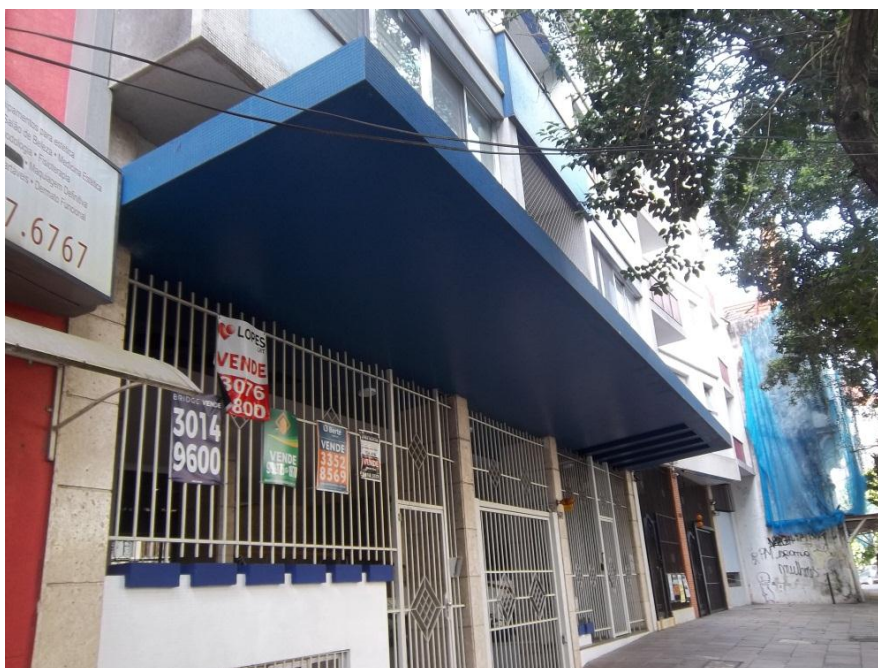
Figura 109 – Vista geral da marquise 4
