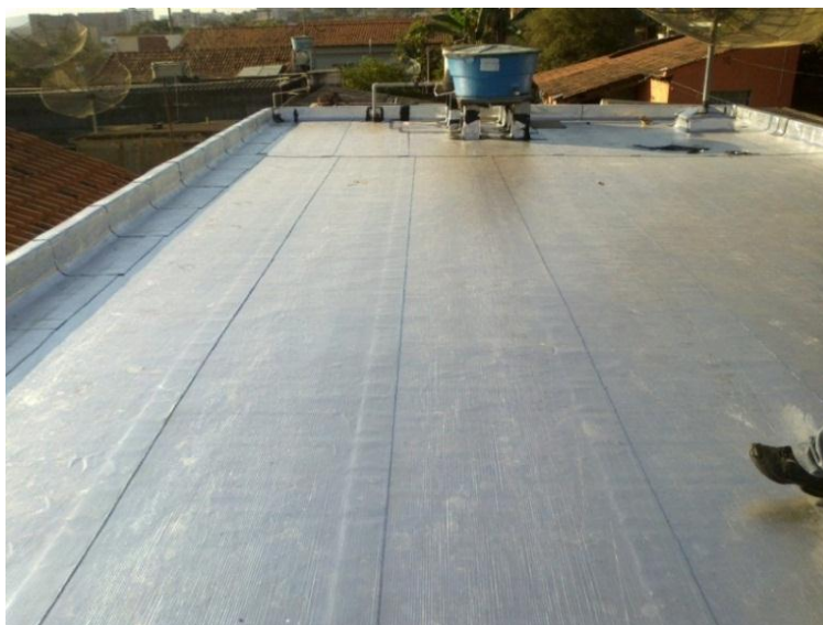
Figura 9 – Exemplo de utilização de manta asfáltica aluminizada em laje de cobertura
