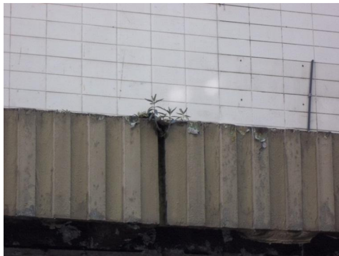
Figura 39 – Vegetação na platibanda da marquise 1
