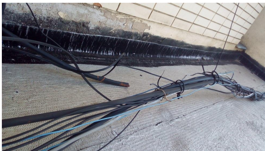
Figura 56 – Execução do rodapé na região B
