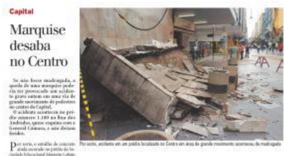
Figura 20 – Acidente com queda de marquise na Rua dos Andradas
