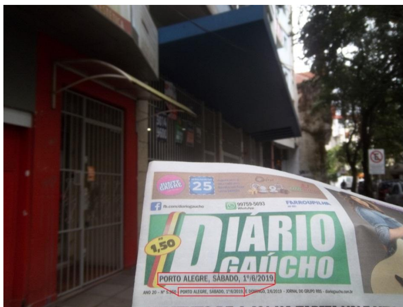
Figura 108 – Comprovação do dia da última inspeção na marquise 4
