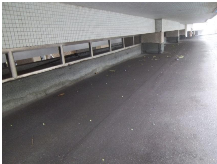
Figura 123 – Condição da parte superior da marquise 4 após limpeza
