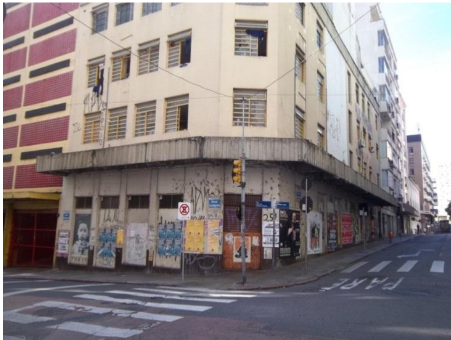
Figura 25 – Outro ângulo da fachada da edificação da marquise 1
