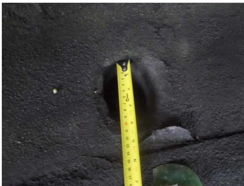
Figura 115 – Indicação do diâmetro do duto destinado para escoamento das águas pluviais
