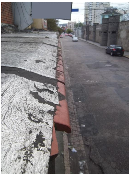
Figura 53 – Existência de plaquetas cerâmicas no bordo livre da marquise 2
