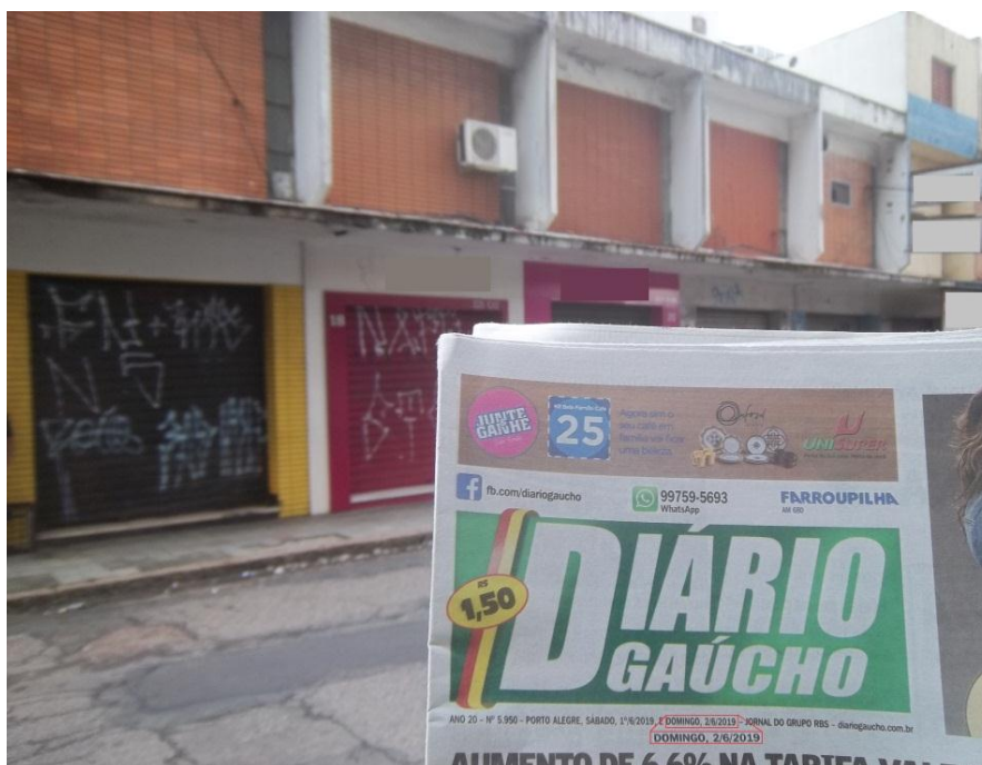
Figura 50 – Comprovação da data da última vistoria na marquise 2
