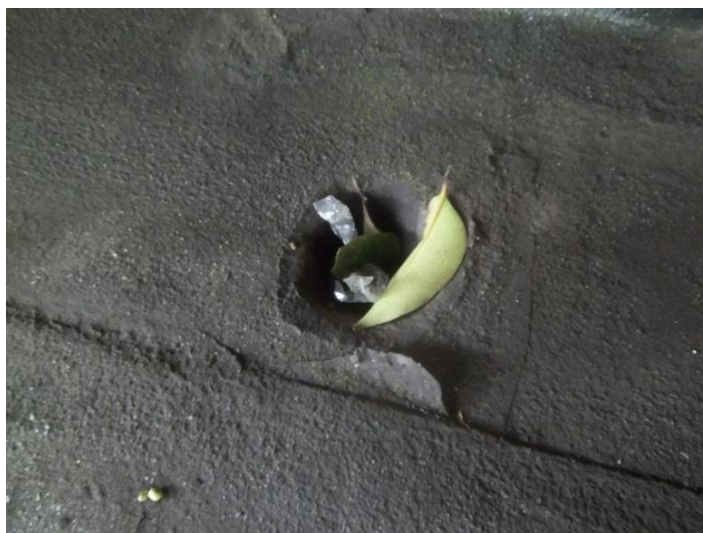
Figura 127 – Deposição de detritos no duto de escoamento da água
