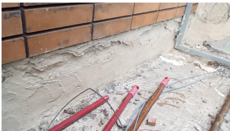
Figura 64 – Rodapé protegido com argamassa
