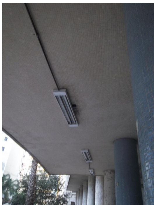
Figura 89 – Parte inferior da marquise da Escola de Engenharia da UFRGS
