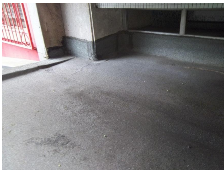
Figura 124 – Detalhe para a região do engaste após limpeza
