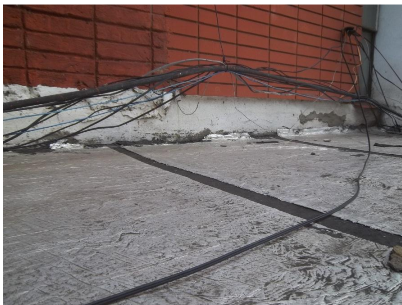
Figura 58 – Detalhe do rodapé da região C
