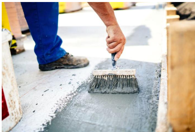
Figura 14 – Aplicação da argamassa polimérica utilizando brocha
