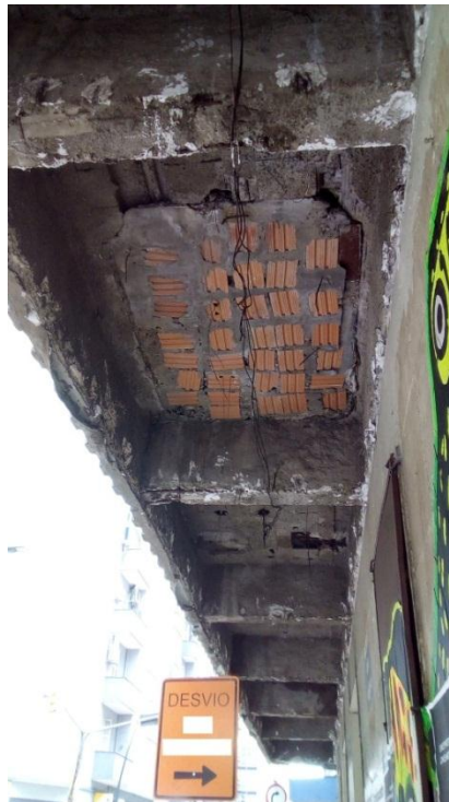
Figura 27 – Imagem da parte inferior da marquise nº 1
