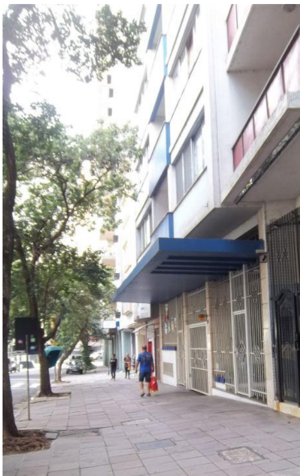
Figura 107 – Vista lateral da fachada do edifício da marquise n°4
