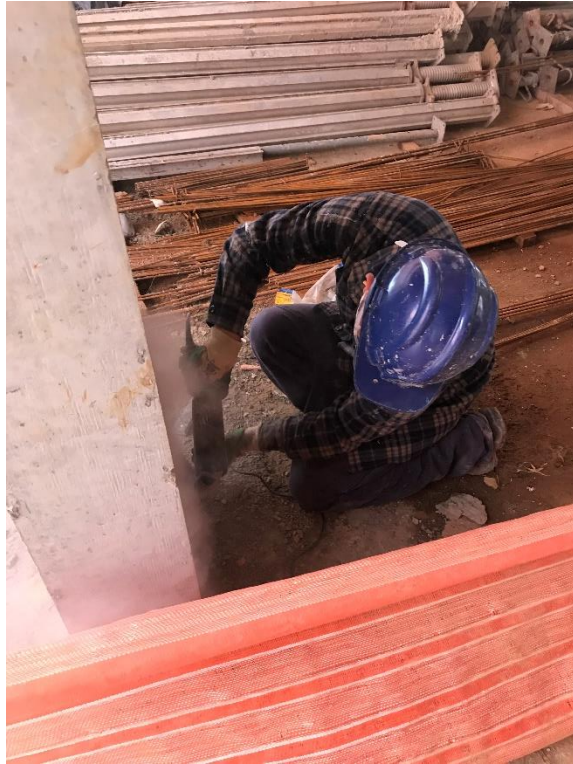
Figura 15 – Lixamento do concreto com lixadeira especial para concreto e disco diamantado
