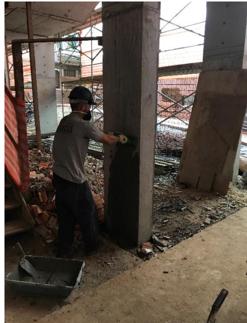
Figura 8 – Aplicação do chapisco adesivo (painel 1 – pilar 21)
