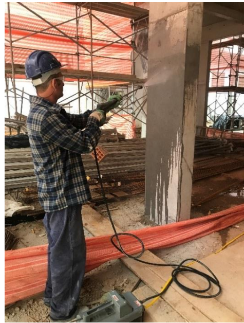
Figura 6 – Lavagem à frio do painel 4, pilar 23
