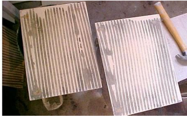
Figura 24 – Tardoz de peça cerâmica preenchido insatisfatoriamente
