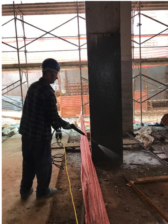
Figura 16 – Lavagem à frio do concreto após lixamento
