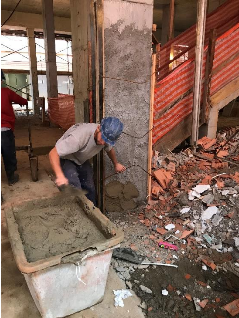
Figura 9 – Execução do emboço (painel 2 – pilar 21)
