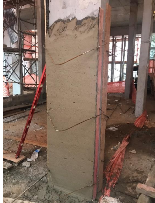
Figura 10 – Aspecto final do revestimento de argamassa (painel 4 – pilar 21)
