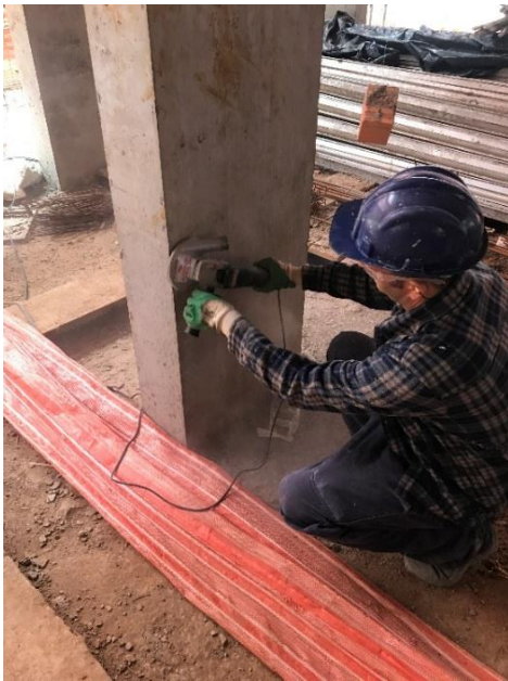
Figura 5 – Lixamento do painel 3, pilar 23
