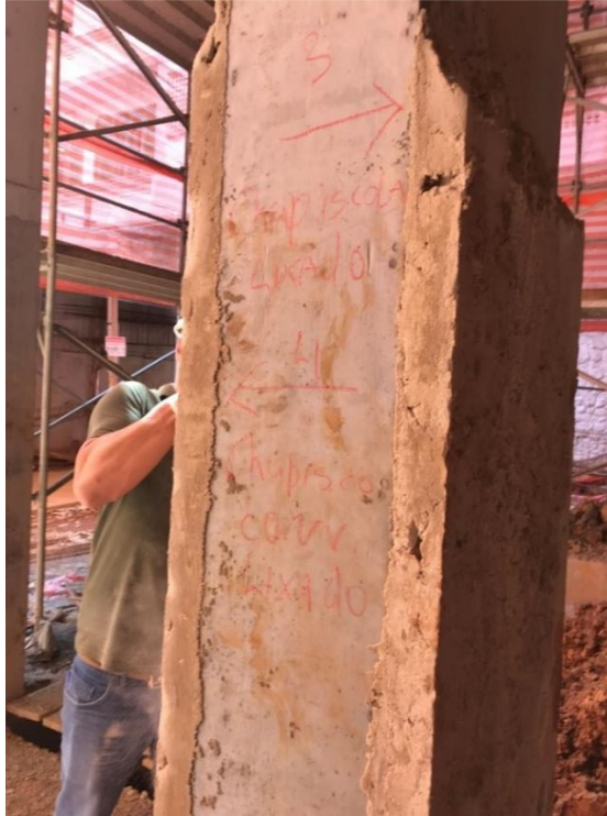
Figura 12 – Vista lateral dos painéis teste 3 (à direita) e 4 (à esquerda), respectivamente: chapisco adesivo e chapisco convencional, ambos aplicados em superfície de concreto lavada a frio e lixada
