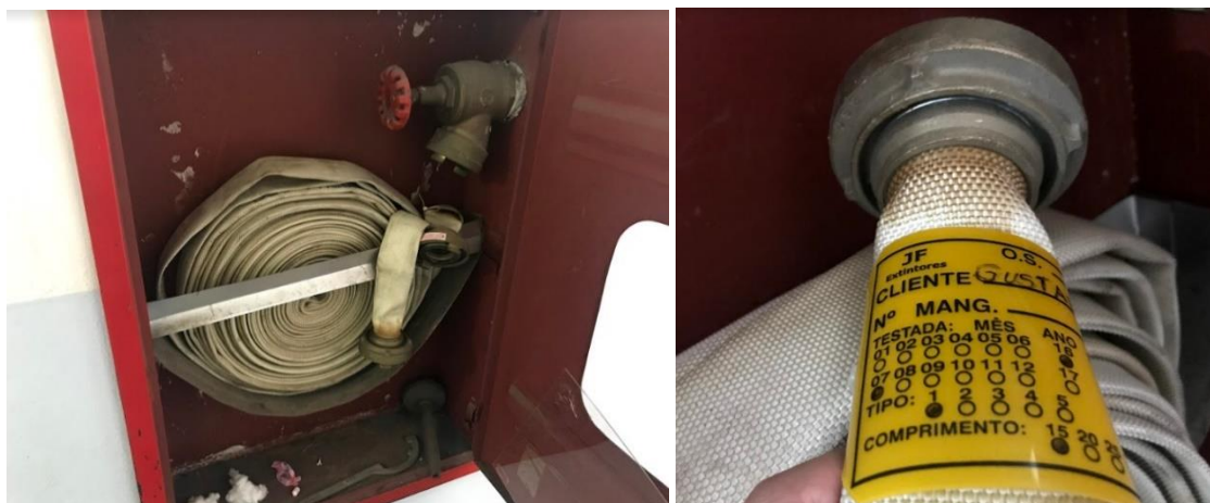
Figura 19 - Hidrantes e dados do último teste
