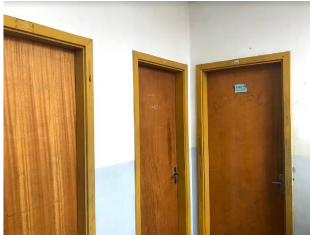
Figura 10 - Portas das salas de aula em madeira
