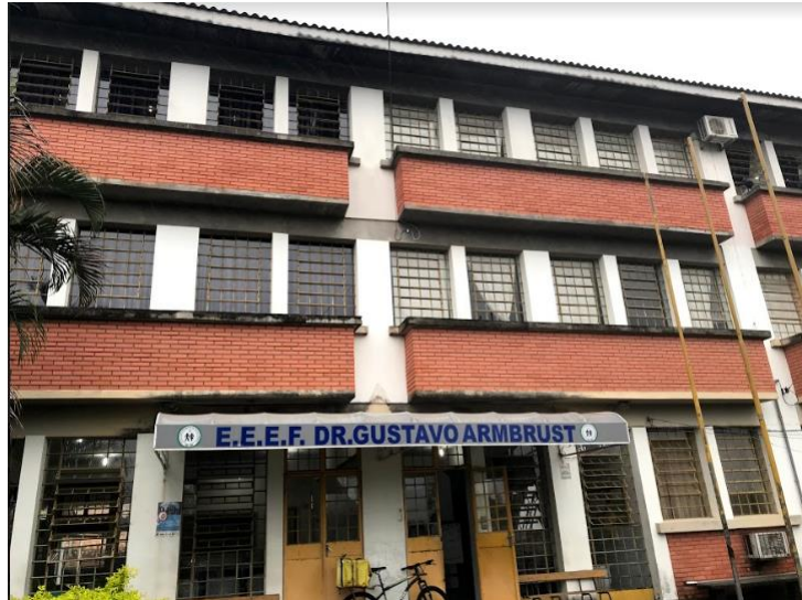
Figura 8 - Fachada da escola
