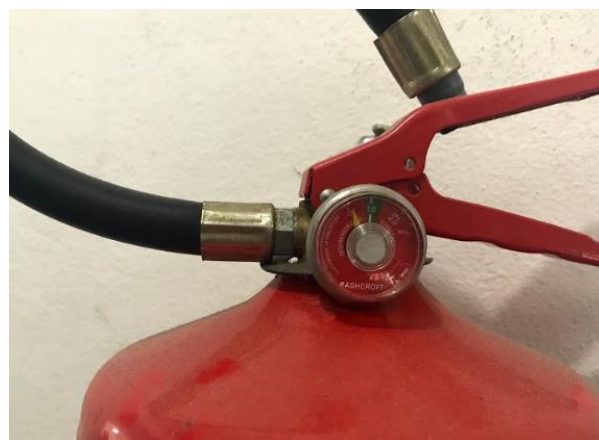
Figura 15 - Extintor despressurizado
