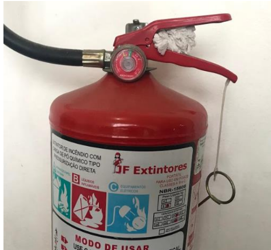
Figura 16 - Extintor sem lacre e trava de segurança solta
