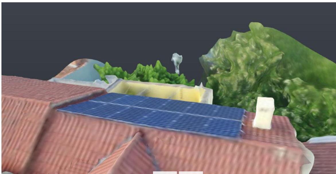
Figura 19 - Obstáculos que causam sombreamento no sistema de número 7
