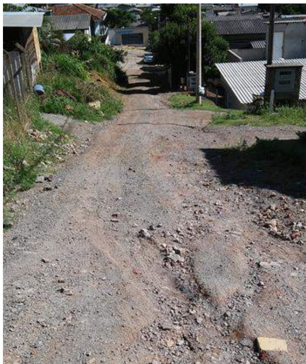
Figura 8 - Problemas mencionados pelos alunos de ausência de calçadas para a circulação de pessoas, ruas estreitas e com buracos
