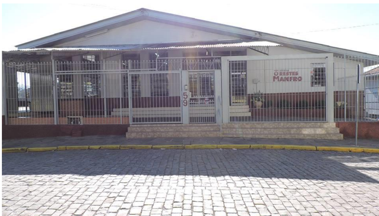
Figura 3: Fachada da escola
